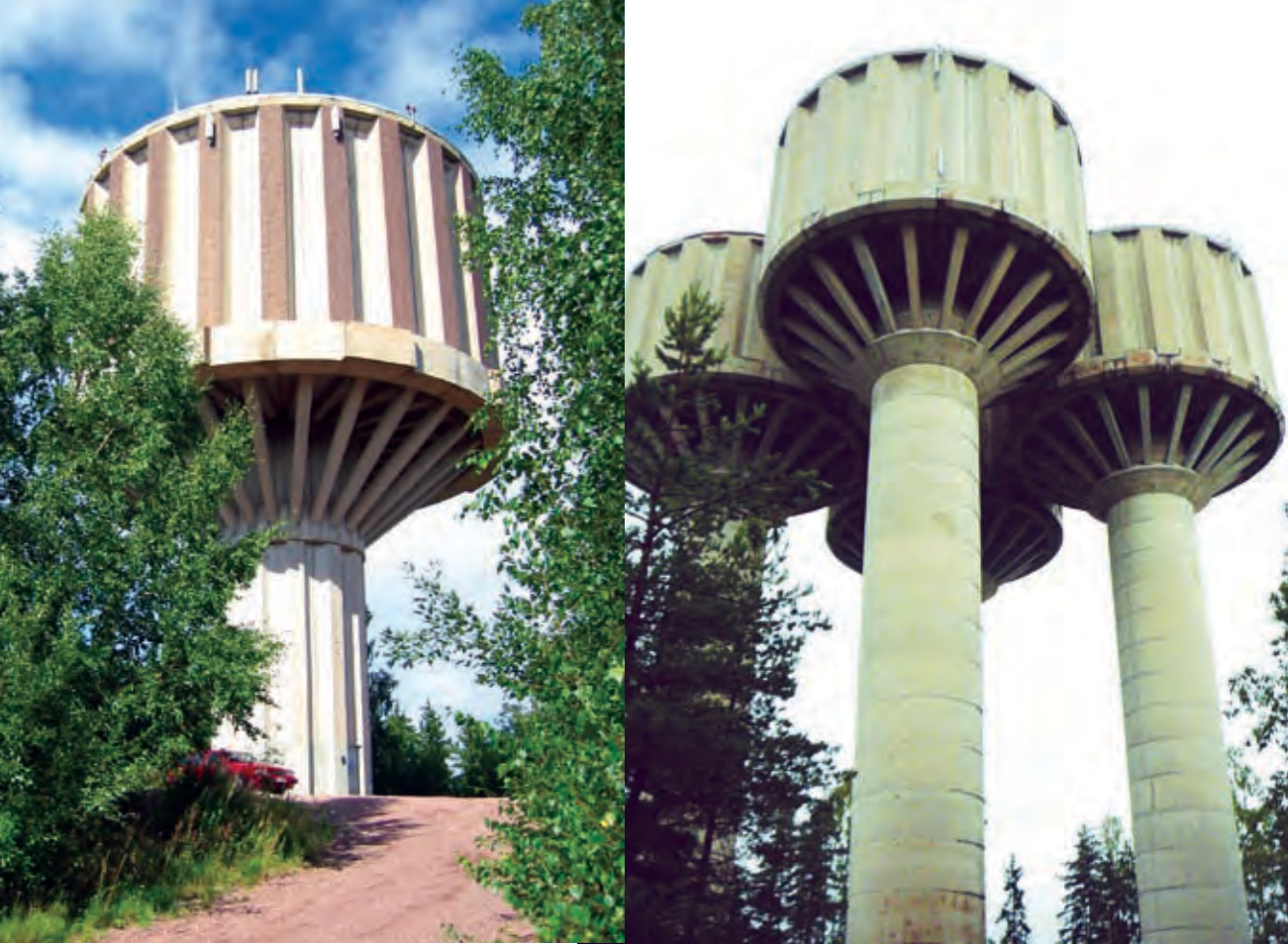
Kuva 2a ja b. Vasemmalla vesitorni Porvoosta (Juuti 2003). Oikealla Vantaan Korson vesitorni, joka koostuu neljästä toisissaan yhteydessä olevasta osasta. (Juuti 2006)
