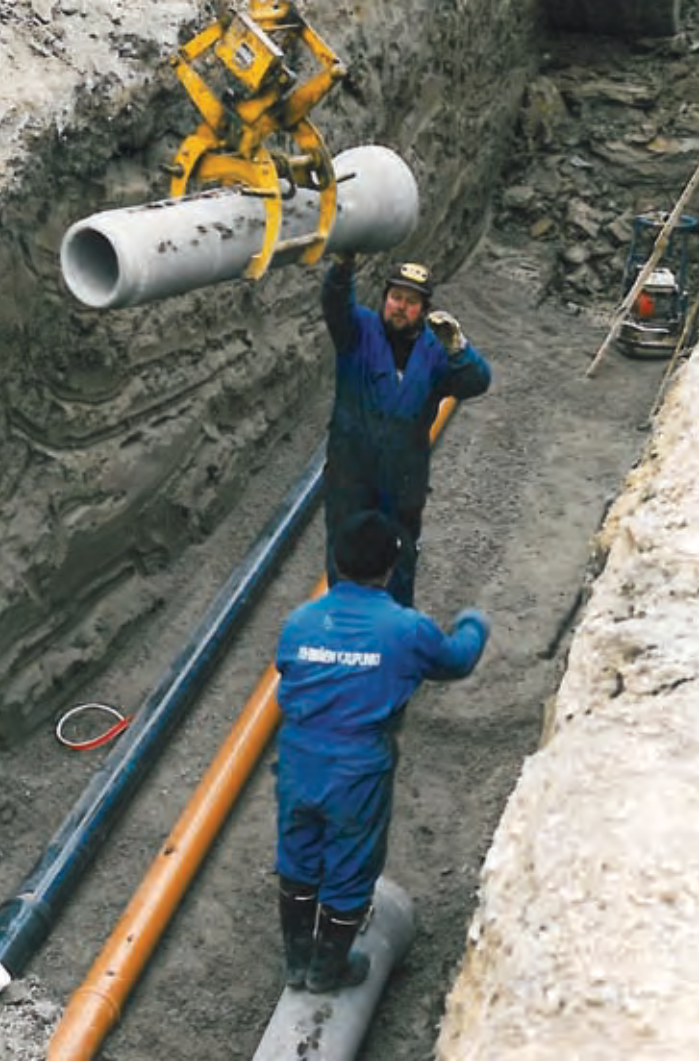
Kuva 4a ja b. Vasemmalla Erkyläntien kaivanto 21.11.1994. Kuvassa Jukka Koskinen ja Pasi Kiuru (selin). Monttuun laitetaan 160 mm vesijohto sekä viemäriputki ja 300 mm sadevesiputki. Oikealla Koskinen ja Pertti Hellsten, KVR-mestari. (Koskinen J. 1994)
