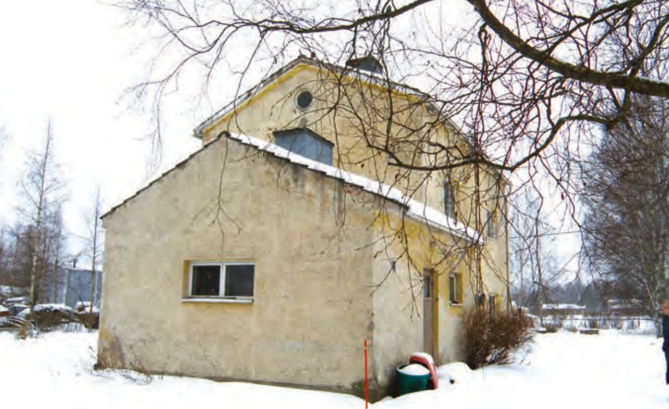
Kuva 9. Juppalan vesilaitos. Juppalan pumppuasemarakennus valmistui vuonna 1950. Laitos jäi pois käytöstä vuonna 1984. (Rajala 2009)
