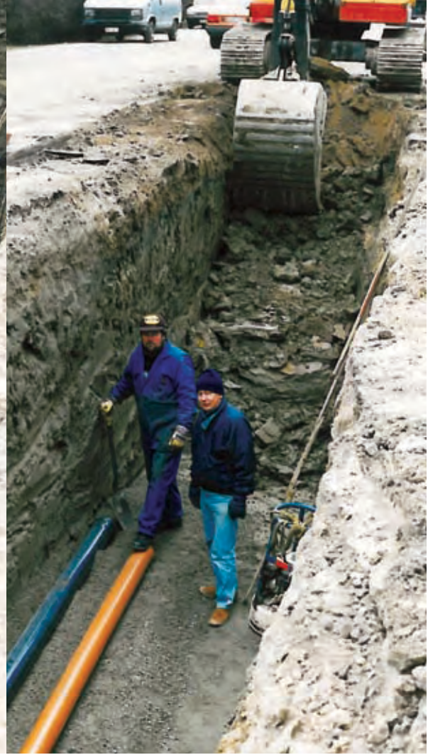
Kuva 4a ja b. Vasemmalla Erkyläntien kaivanto 21.11.1994. Kuvassa Jukka Koskinen ja Pasi Kiuru (selin). Monttuun laitetaan 160 mm vesijohto sekä viemäriputki ja 300 mm sadevesiputki. Oikealla Koskinen ja Pertti Hellsten, KVR-mestari. (Koskinen J. 1994)
