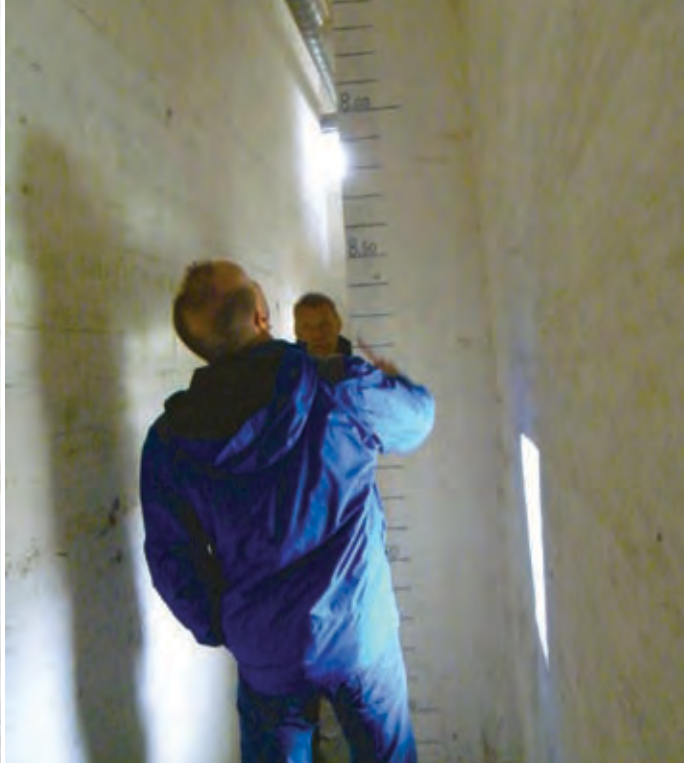
Kuva 7a ja b. Vesilinnan huoltotiloja. Oikeanpuoleisessa kuvassa vanha vesisäiliöiden pinnan korkeuden osoittava asteikko. (Rajala 2009)
