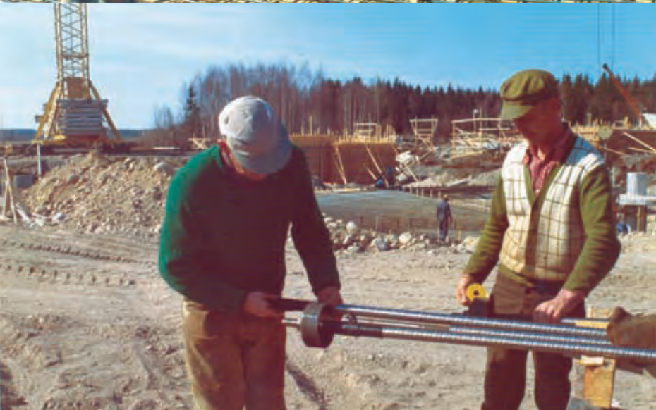
Kuva 6a, b ja c. Jätevedenpuhdistamoa rakennetaan. (Riihimäen Vesi)
