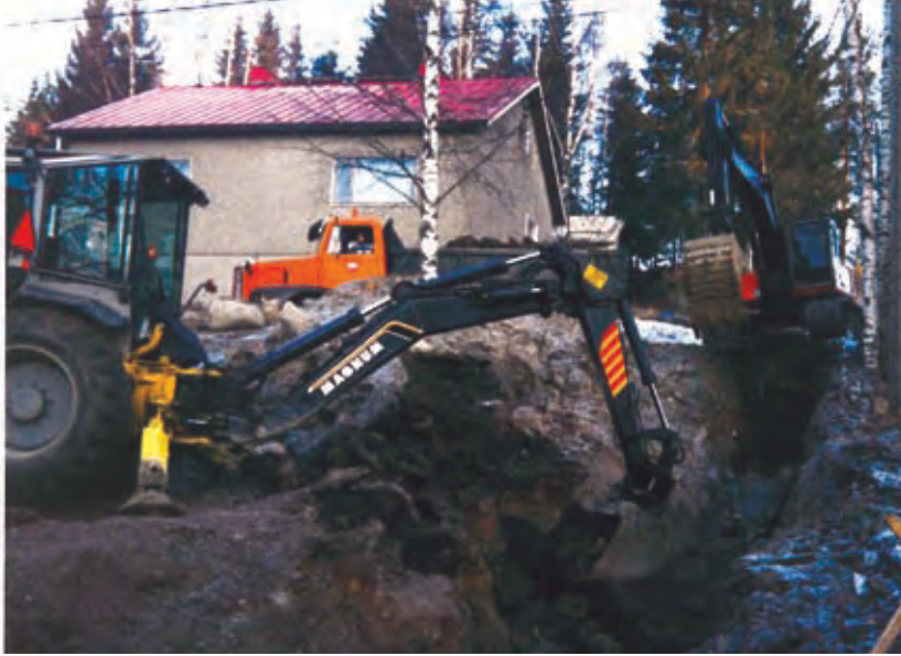
Kuva 5. R. Javanainen istuu Magnum-kaivurin puikoissa. Kuvassa Kokon alueen töitä. (Koskinen J.)
