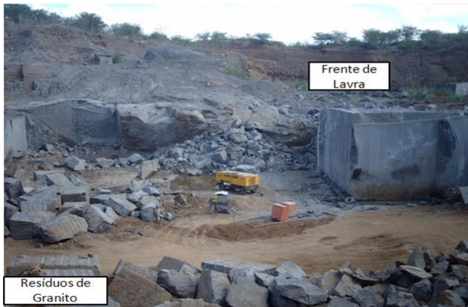
APÊNDICE C - Frente de lavra apresentando grande quantidade de resíduos de granito na mineração Coto no município de Parelhas-RN
