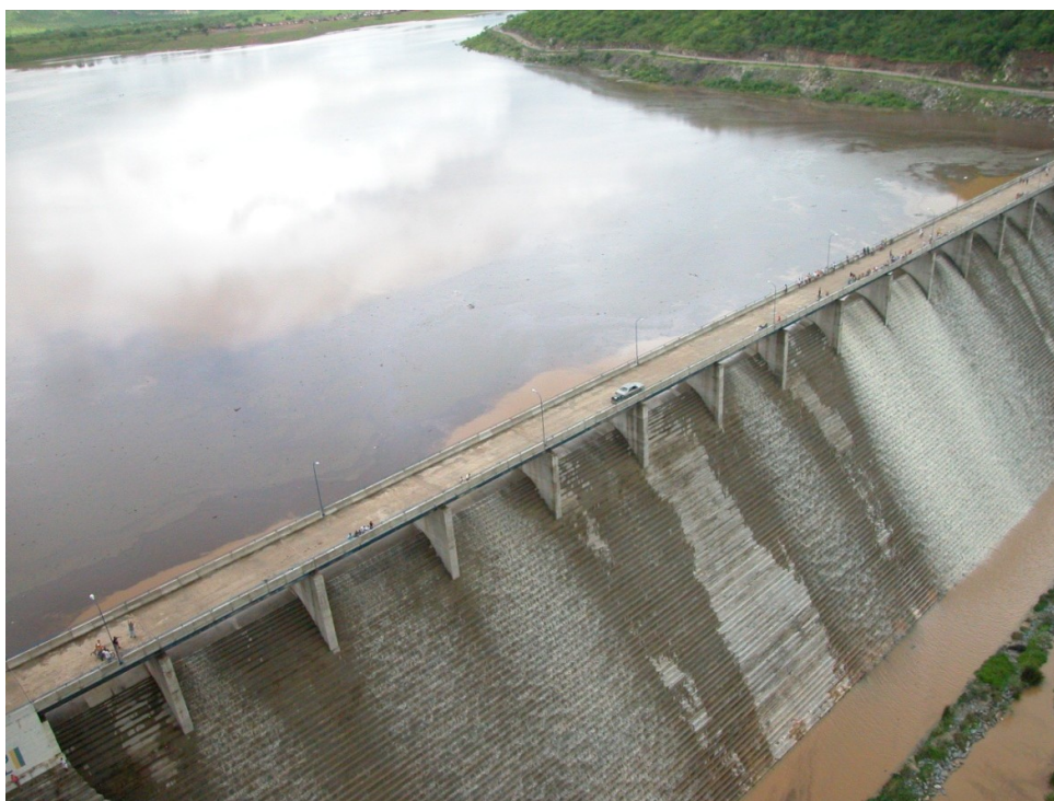
Figura 5.3 – Reservatório Argemiro de Figueiredo (Acauã).
