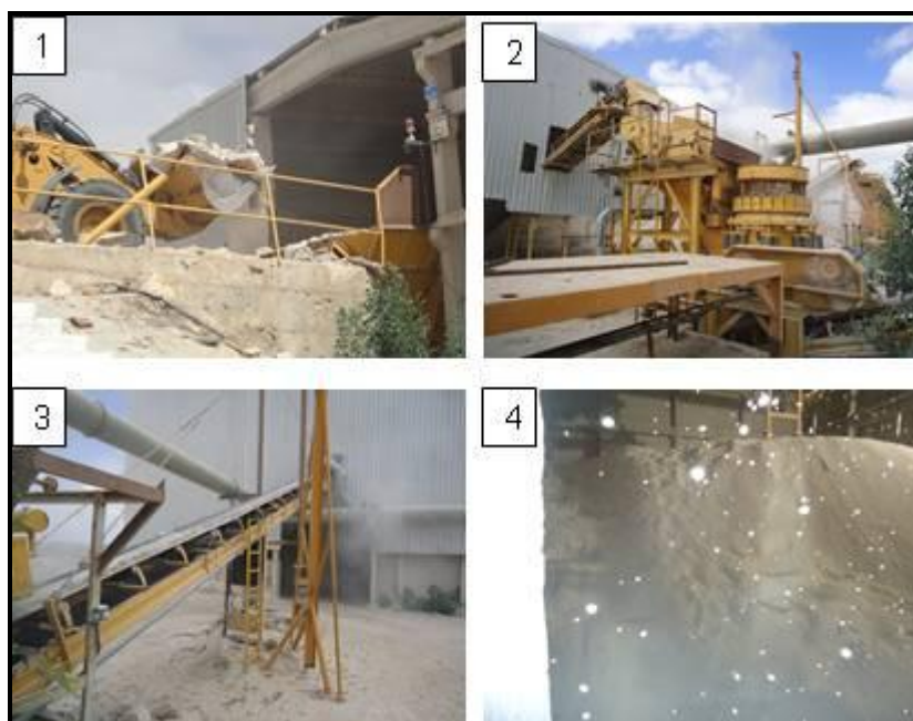
Figura 10 – (1) Descarga, (2) processamento, (3) transporte e (4) armazenamento do material
