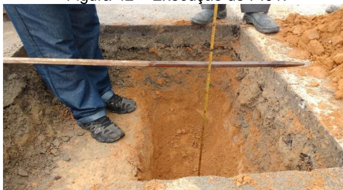
Figura 42 – Execução do PI01.
