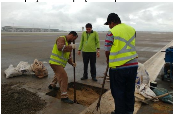
Figura 12 – Execução do poço de inspeção no pavimento aeroportuário estudado.
