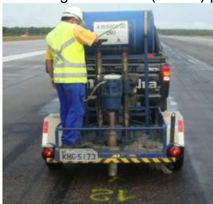
Figura 27 – Execução de sondagem rotativa (SD-12) para coleta de amostras.
