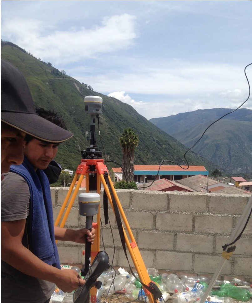
FIGURA N°10: Instalación del Cabezal Receptor.
