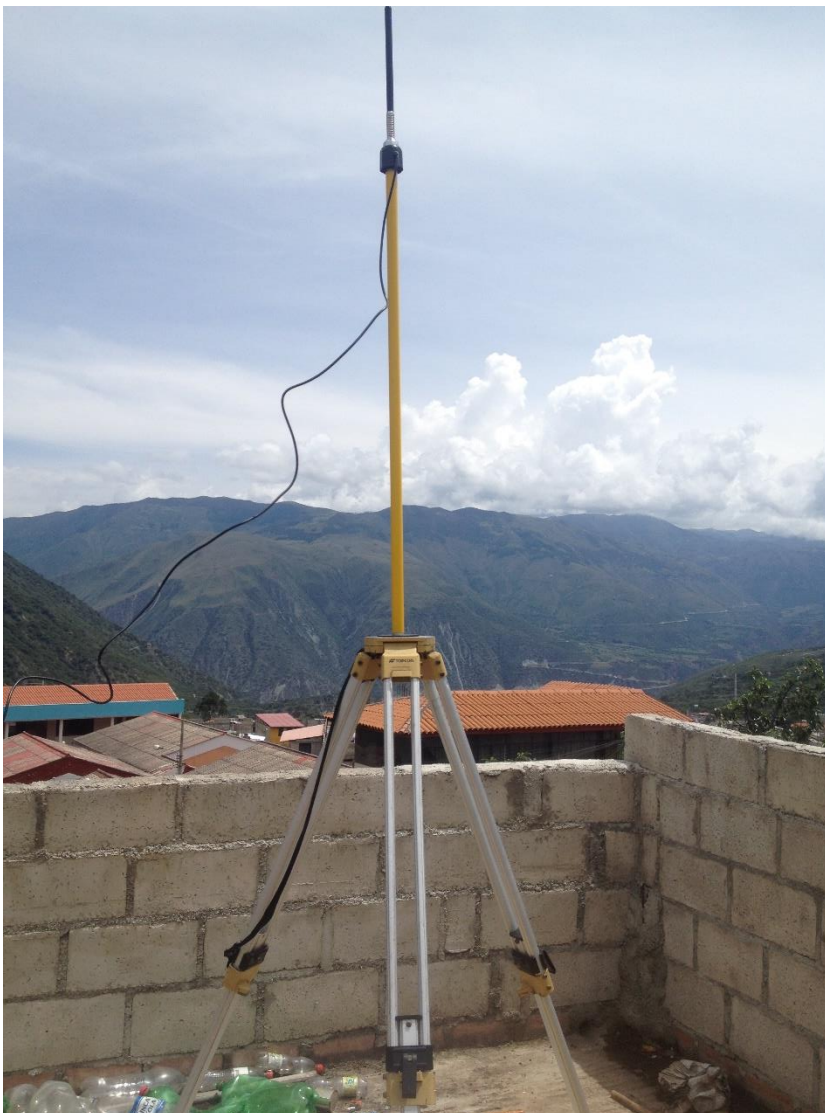
FIGURA N°09: Instalación de la Antena Base del RTK R10.
