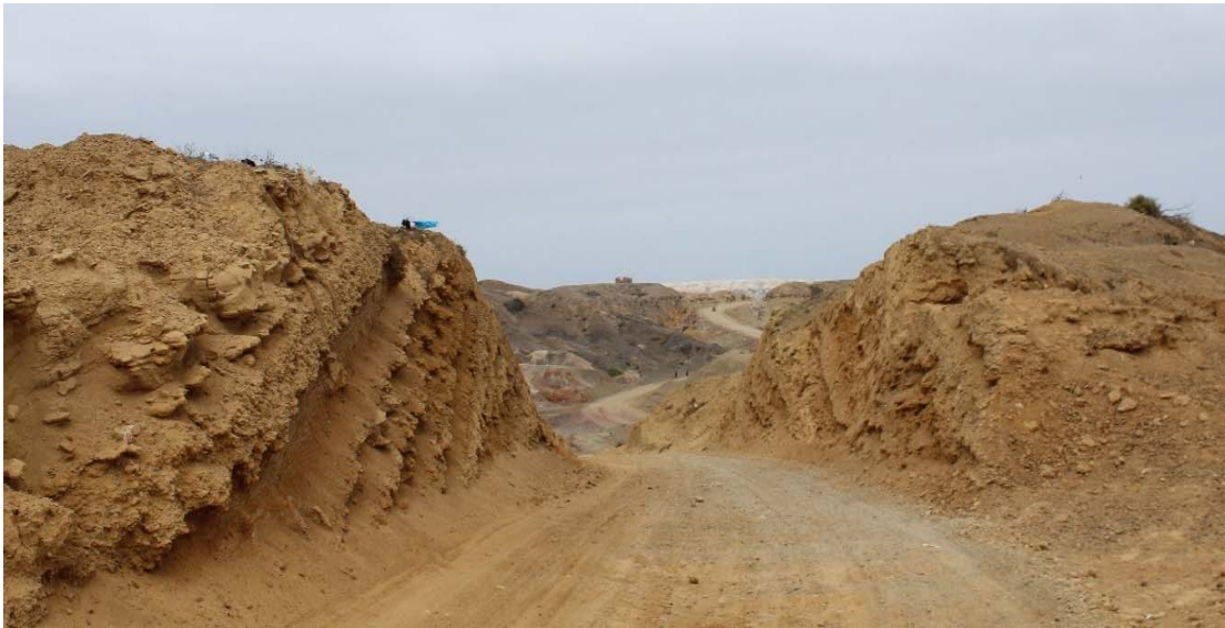
Figura 2.71 Carretera de La Nueva Islilla a La Islilla Fuente: Elaboración Propia
