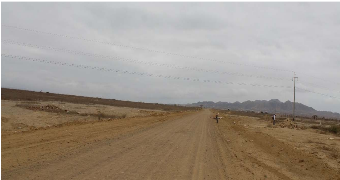
Figura 2.92 Proyecto de la Carretera La Isilla Fuente: Elaboración Propia
