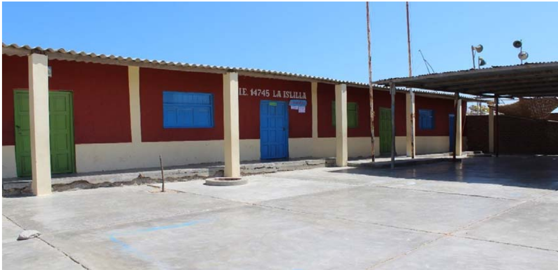
Figura 2.8 Colegio Primario. Almirante Miguel Grau. Fuente: Elaboración Propia
