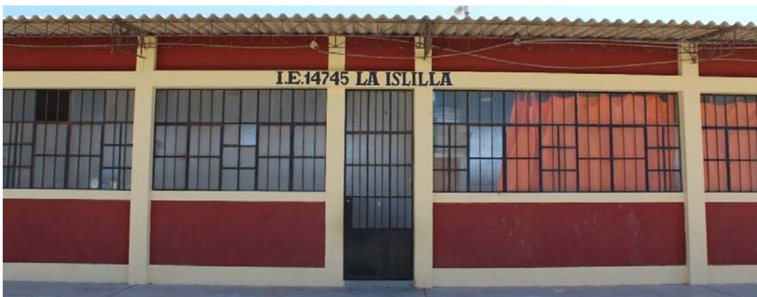
Figura 2.9 Colegio Secundario La Islilla. Fuente: Elaboración Propia
