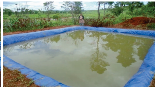
Jalkund at Umeit village
