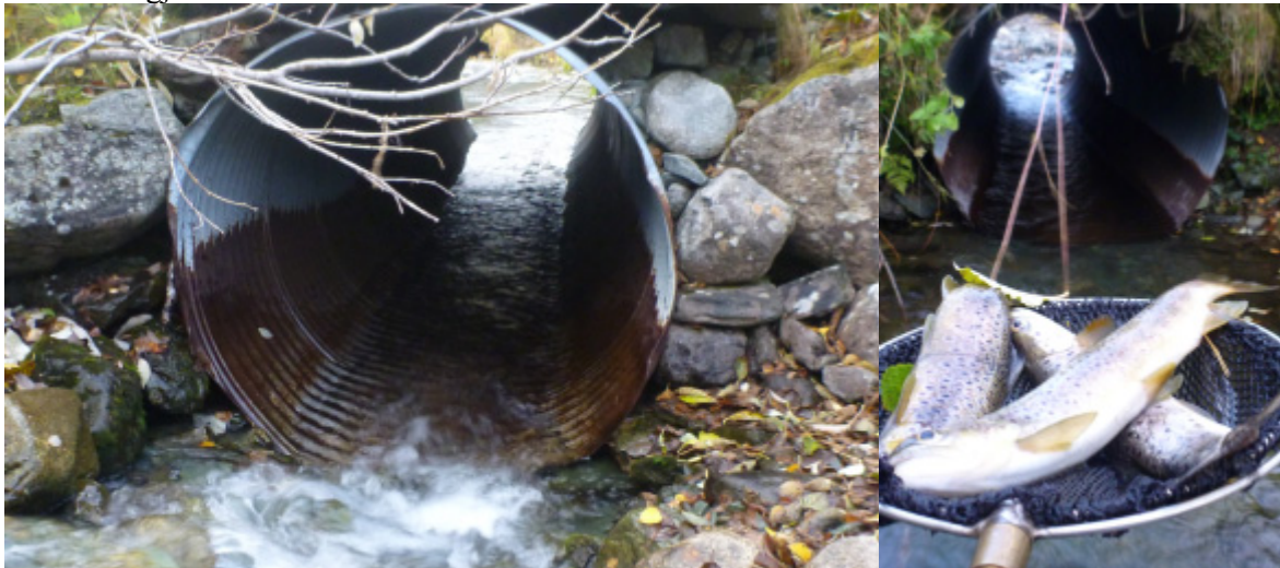
Figur 44. Tilfredsstillende krysning under nederste grusvei i Brattskarvbekken ved moderat og høy vannføring, men vandringshindrende ved lav vannføring. Svært gode forekomster av gytefisk sto i kulpen nedstrøms veien. Største observerte ørret var rundt 40-45 cm, med vekt anslagsvis opp mot kiloen. (Foto: M. Bergan)
