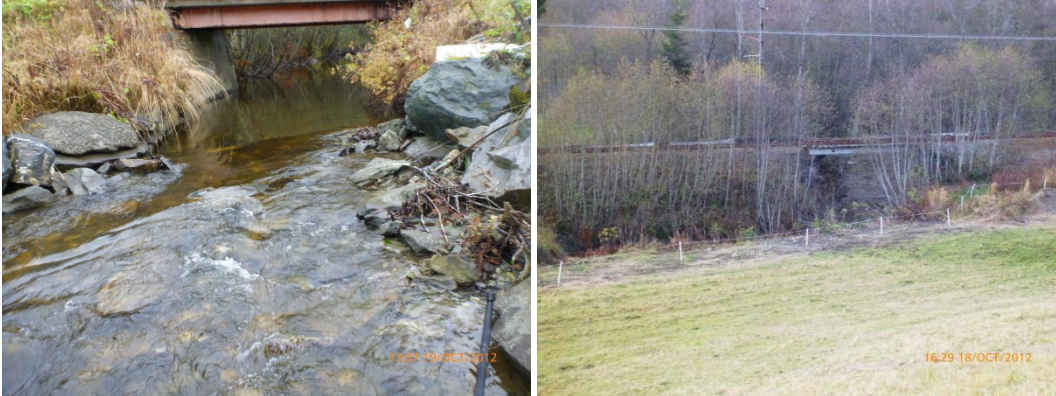
Figur 119. Brukrysnings og bevart elvebunn under kommunal vei (t.v.) og jernbanelinje (t.h.) i Sola (Foto: M. Bergan)
