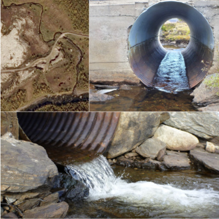
Figur 18. Stillbekken krysses med kulvert under grusvei før munning til Orkla (øverst til venstre), og denne begrenser oppvandring for gytefisk fra hovedelva ved lavere vannføringer. Dette som følge av fall ved utløp kombinert med grunn satskulp (nederst), og lav vanddybde i kulverten (øverst til høyre). (Foto: M. Bergan. Flyfoto hentet fra http://kart.finn.no/ )
