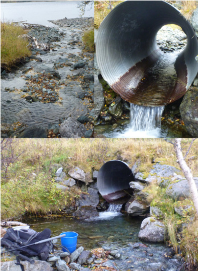
Figur 45. Storåa nedstrøms grusveien, og krysning i kulvert. (Foto: M. Bergan)
