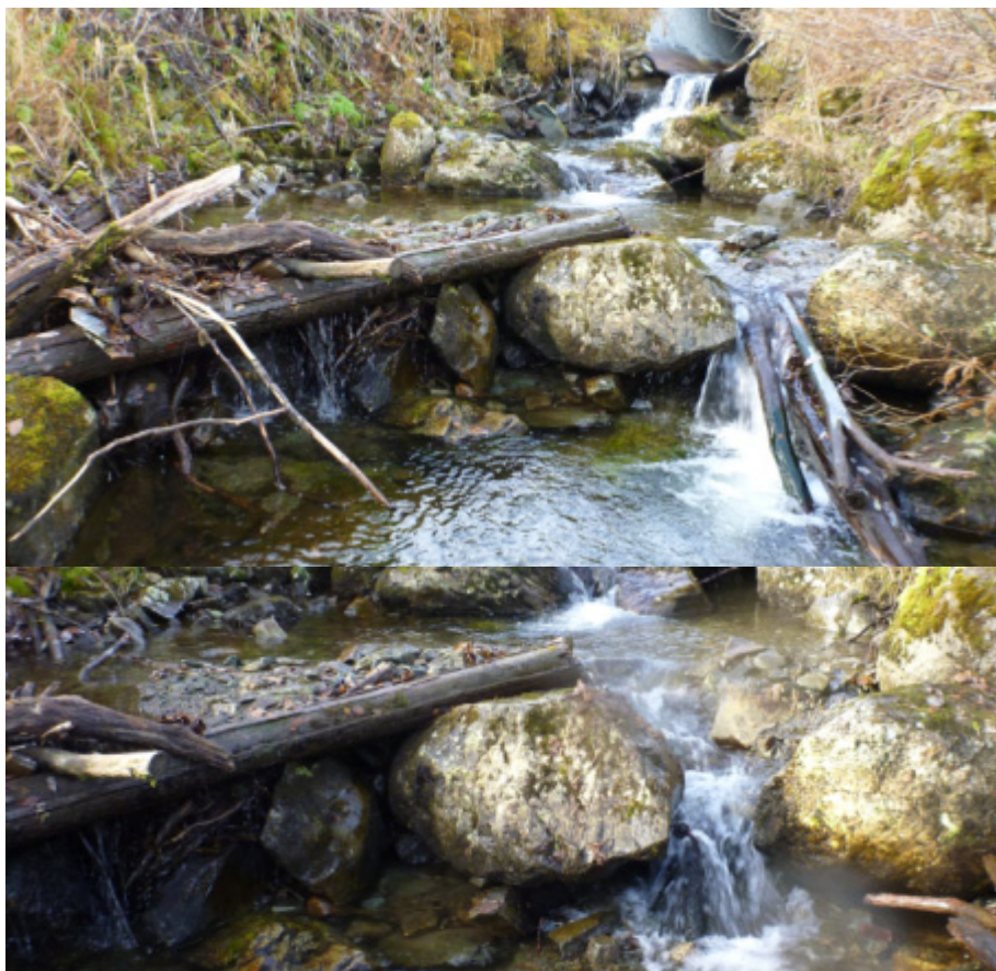
Figur 71. Sterkt vandringshindrende parti nedstrøms kulverten under Garbergsveien før fjerning av driv-ved/trevirke/kvist (øverst) og etter fjerning (nederst). Det ble registrert ungfisk av laks nedstrøms dette partiet. Foto: M. Bergan
