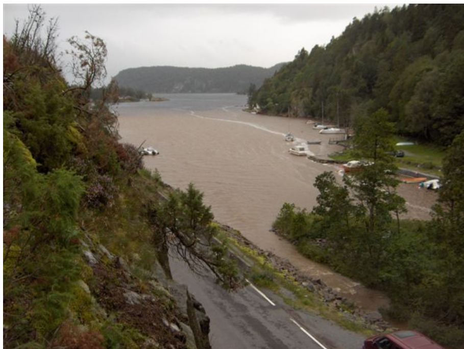
Figur 28. Mørjetjernbekken 16.08.2007 under kraftig regnvær. Fjorden blir grumsete langt utover
