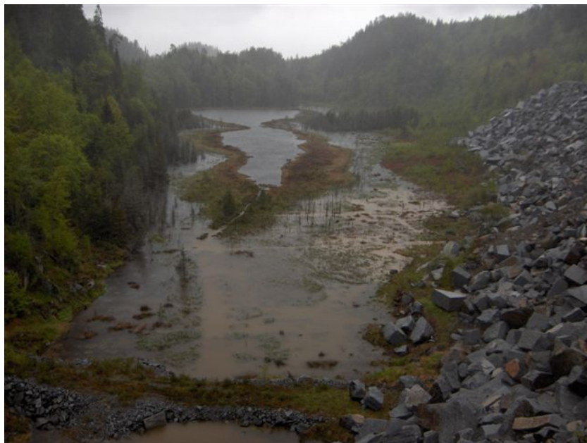
Figur 135. Kombinasjon av infiltrasjon i egne masser, i myr, samt sedimentasjon i et lite myrtjern (øvre Malerødtjern), har effektivt stoppet tilgrumsingen av Malerød/Eikedalsvassdraget. Selv i kraftige regnværsperioder, som her, virker det forbausende bra.
