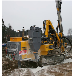
5. Blokkene splittes ved boring
