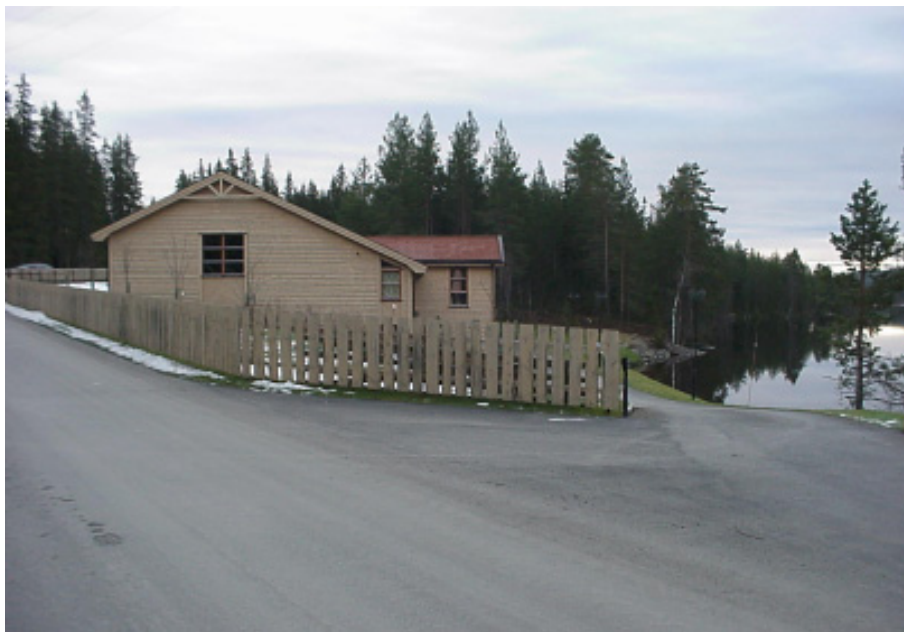
Skjelbreia Vannverk i Vestre Toten kommune
