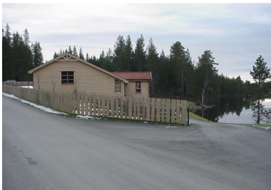
Skjelbreia Vannverk i Vestre Toten kommune
