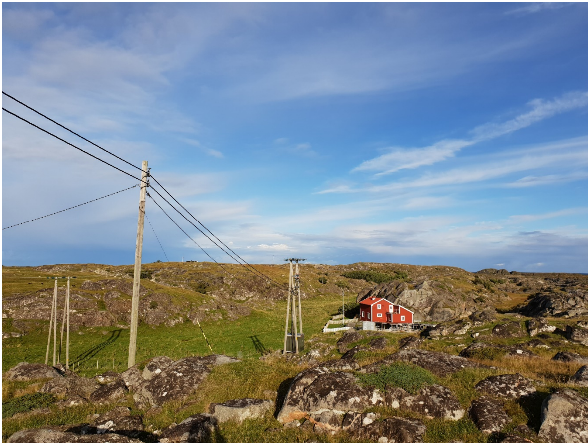
Figur 16. Transformatorstasjonen på Nordøya, ett av alternativene for installasjon av vindturbiner og solcellepaneler.
