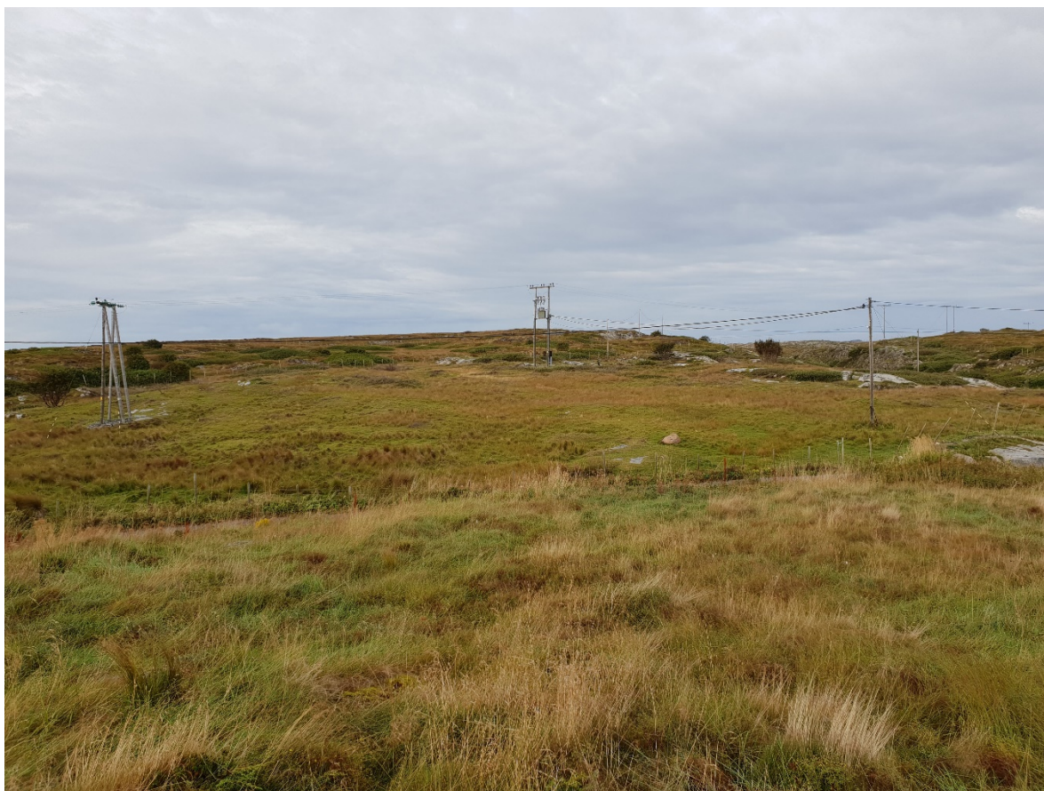
Figur 10. Transformatorstasjonen på Sørburøya. Dette stedet er ett av de alternative punktene for installasjon av vindturbin og solceller.
