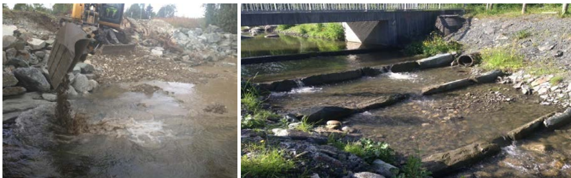
Figur 30. Eksempler på habitattiltak: Vikelva (til venstre: utlegging av gytesubstrat) og Heimdalsbekken (til høyre: etablering av terskler for å sikre vandring forbi et problem punkt under gang- og sykkelbru)
