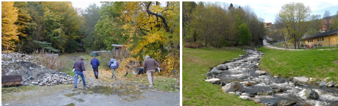
Figur 4. Parti fra Ilabekken før gjenåpning i 2003 (til venstre) og tilsvarende parti etter gjenåpning i 2008 (til høyre). Foto: Trondheim kommune.
