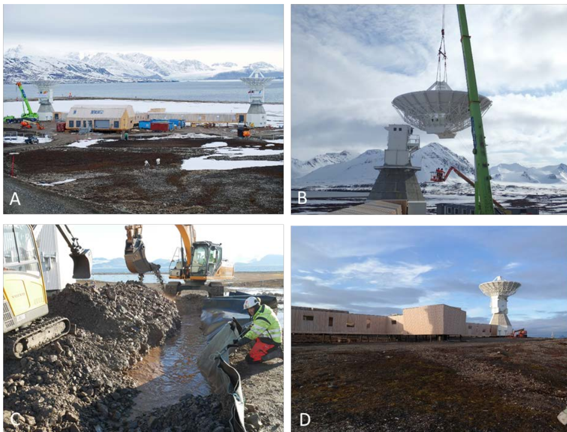
Figur 3.1. Anleggsarbeid gjennomført på det nye stasjonsområdet i 2016. A) og B) VLBI-antennene ble montert på fundamentene i perioden april-juni. C) Dreneringsrenner ble anlagt i september. D) Revegetering rundt bygningene ble gjennomført i september. Foto: Frode Koppang/Kartverket
