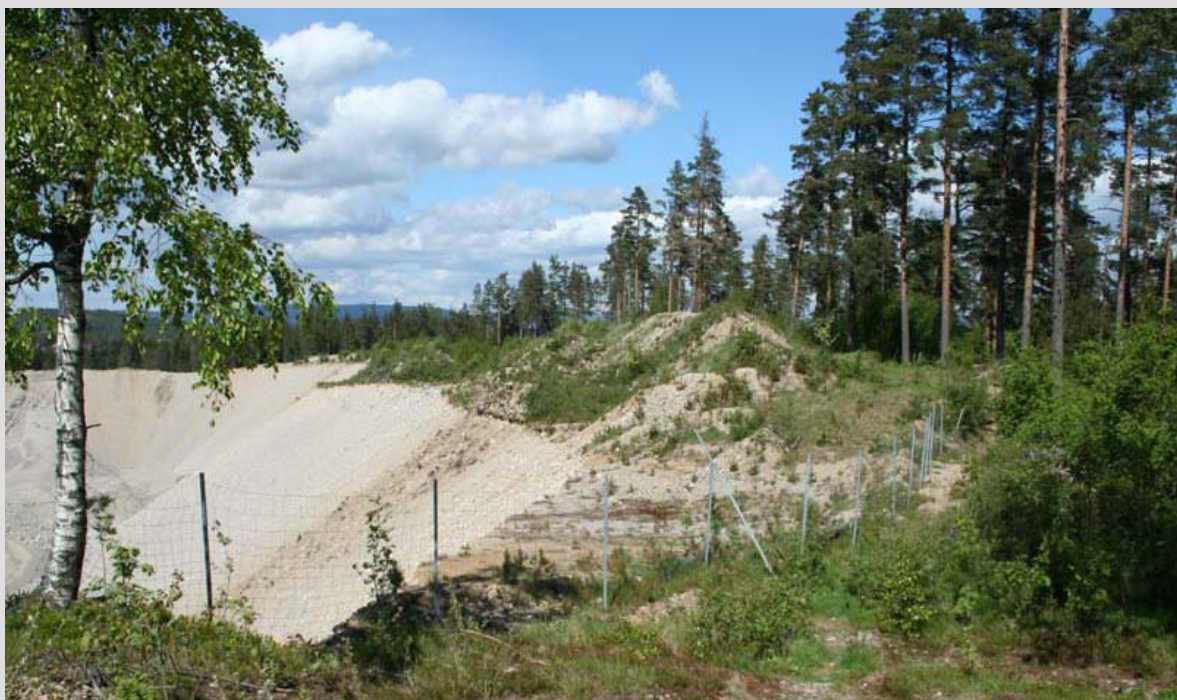
Figur 8. Kanten av grustaket mot øst. Fremdeles står det litt igjen av toppflaten av deltaet som inngår i den vestlige delen av foreslått vernet område. Legg merke til lagring av overskuddsmasser i området.
