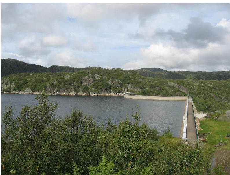
Store Kvernevatn med dam på utløpet. Foto: Trygve Hesthagen.
