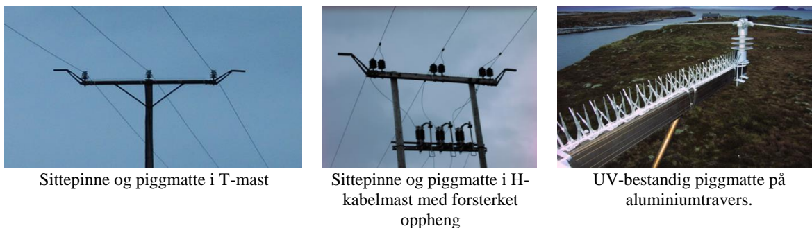
Figur 21. Traversforlenger kombinert med sitteavviser (Foto: Terje Sagvik).
