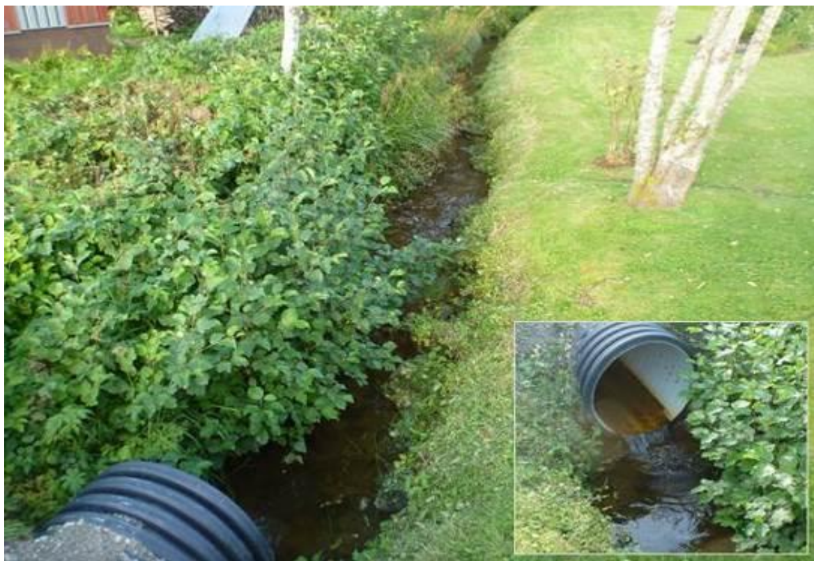
Figur 65. Brautbekken til Skårvollbekken var opprinnelig en viktig gytebekk for sjørret på strekninger opp mot 1 kilometer, og er fortsatt sjørretførende. Den er imidlertid sterkt kanalisert og har flere inngrep som er vandringshindrende, og har trolig tapt mye sine opprinnelige kvaliteter. (Foto: Morten Andre Bergan).
