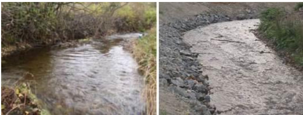
Figur 31. Kaldvella ovenfor E 6 i 2008 (t.v.) og samme strekning 2011 etter steinsetting (t.h.). (Foto: Morten Andre Bergan).
