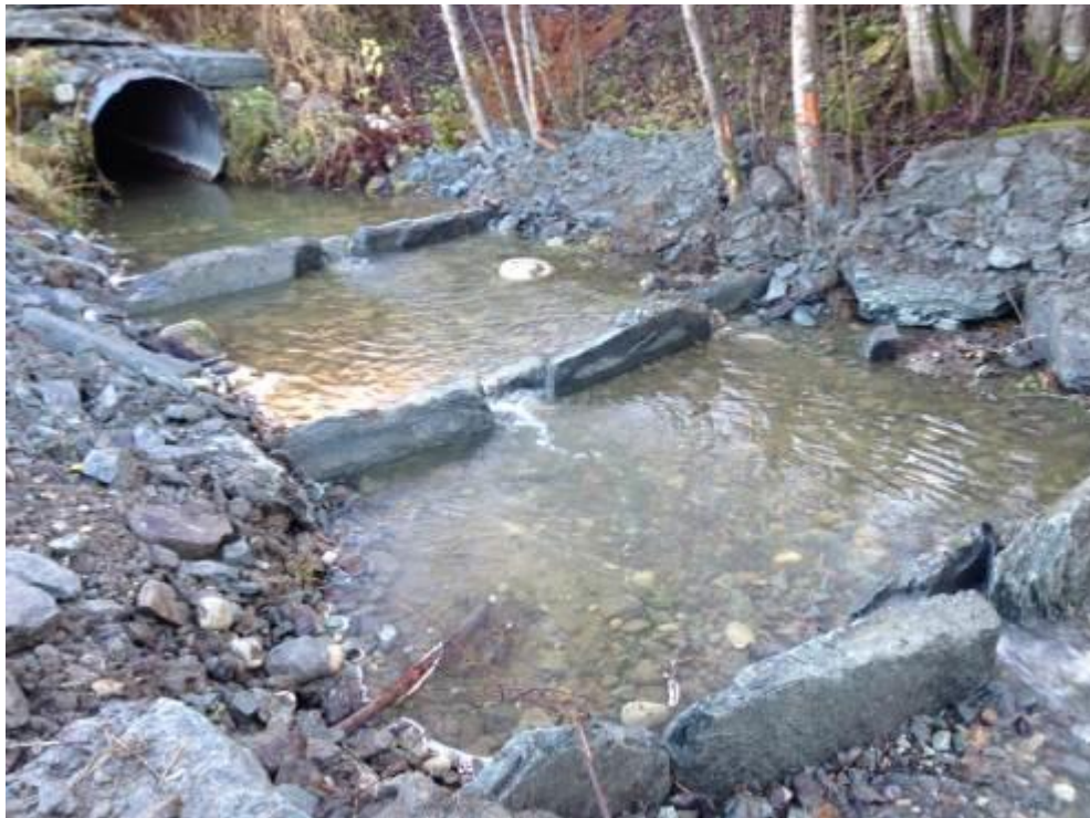
Figur 22. Veikryssning under Fv. 707 i Buskleinbekken etter tiltak. (Foto: Terje Nøst). Bekken var fisketom høsten 2013.
