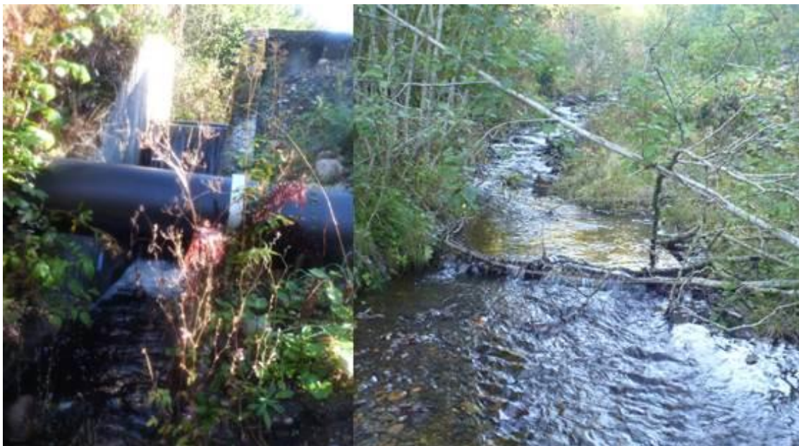
Figur 42. Sideløp i Kaldvella, parallelt med oppsatt demninger, der sjøørret opprinnelig hadde frie vandingsveier. Dette er i dag oppdemmet til vanninntak og stengt med en ytterligere demning. (Foto: Morten Andre Bergan).
