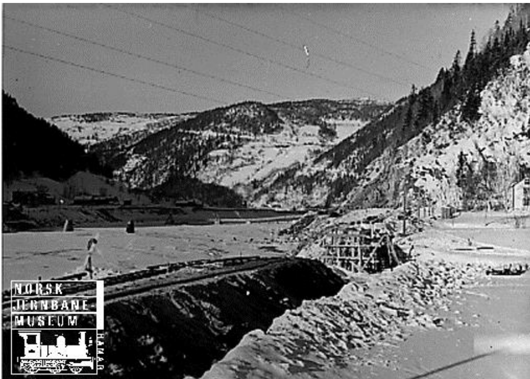
Figur 72. Rogga i 1941, under bygging av ny jernbanebru etter flommen året før. Rogga munner i Gaula uten fallgradient av betydning. (Foto hentet fra Norsk Jernbanemuseum).
