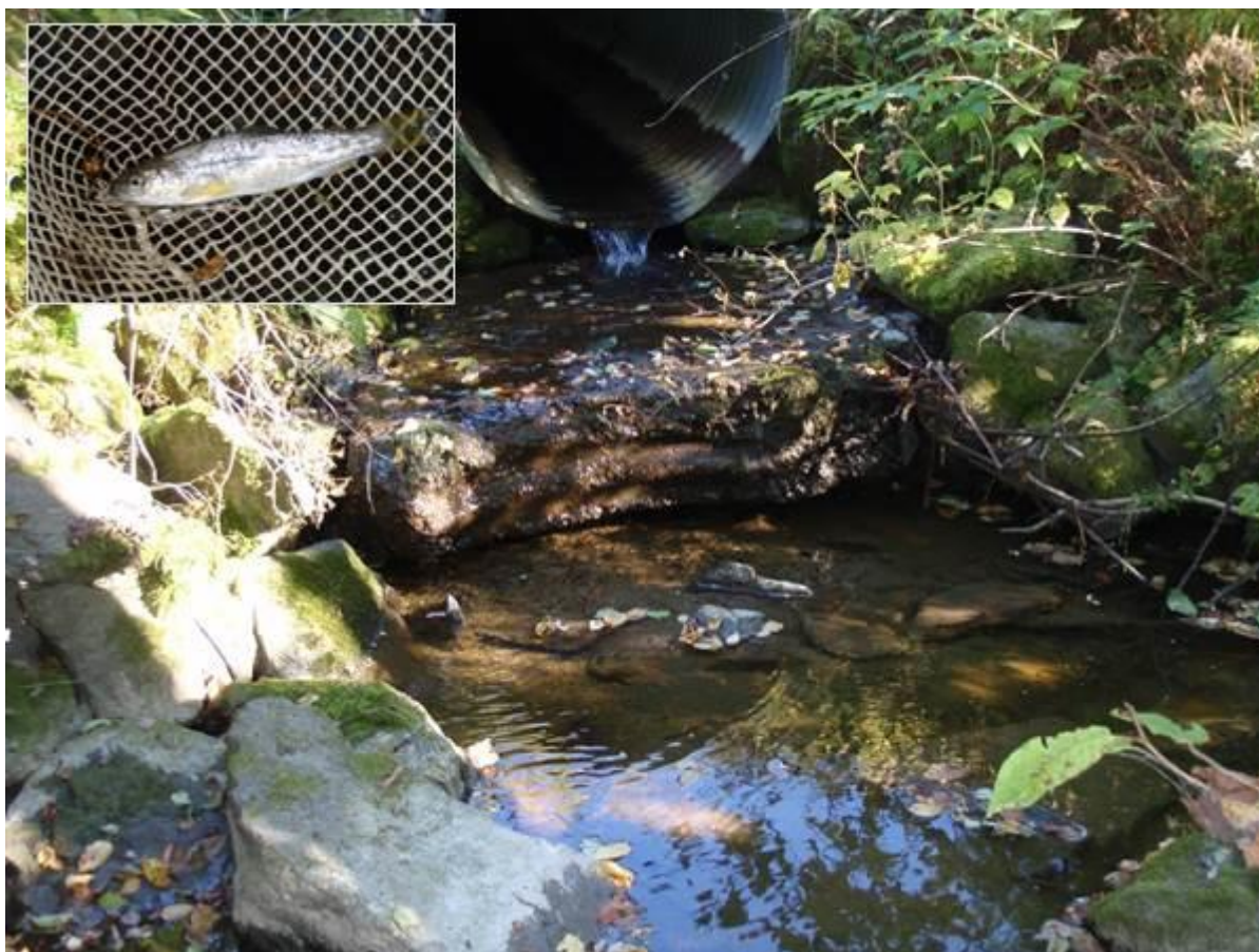
Figur 21. Vandringsbarriere under Fv. 707 i Buskleinbekken før tiltak, og årsyngel av ørret (innfelt) fra 2008. (Foto: Morten Andre Bergan).
