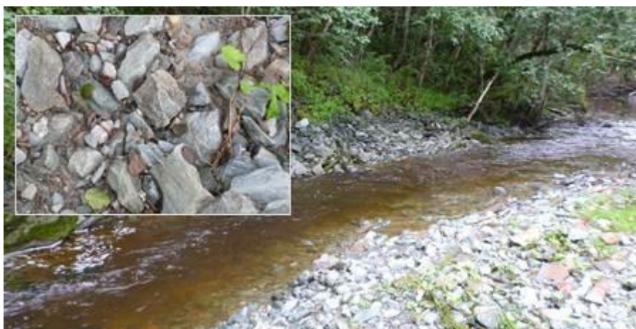
Figur 44. Møsta. Relativt ny (ikke synlig på flyfoto fra 2011) steinsetting/erosjonssikring er utført utelukkende ved bruk av ukurant skuttstein, uten bruk av elvegrus, med bekkeløputforming som renne/strykparti. Dersom hele anadrom strekning steinsettes på denne måten vil Møsta være ødelagt som sjørretvassdrag. (Foto: Morten Andre Bergan).
