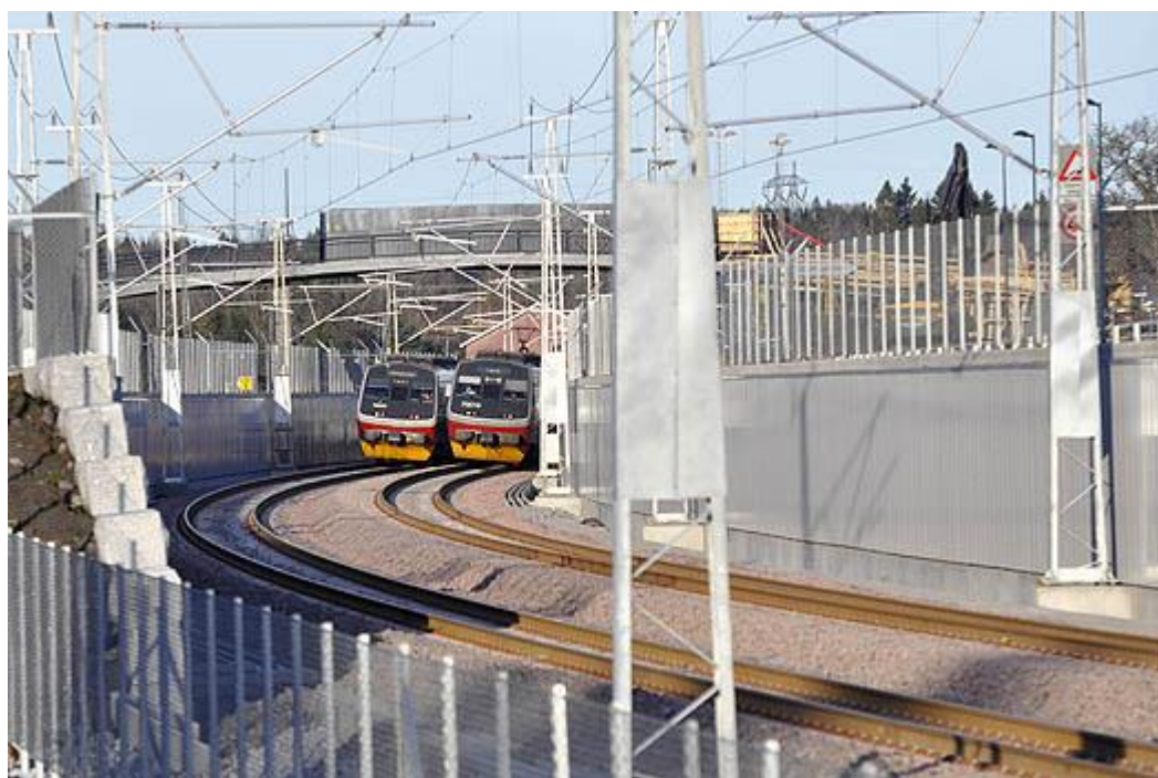
Figur 5.2 Gjennom Barkåker går sporet i et nedsenket betongtrau. (Foto: Freddy Samson Fagerheim)
