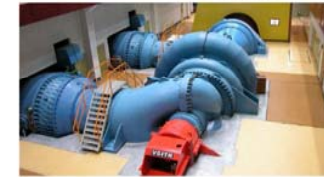
Hornbergbecken of Pumped Hydro Plant Wehr (Schluchseewerke)
