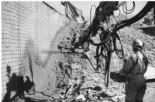
Figur 4-4. Sprøytebetong med resirkulert tilslag på Gaustadbekkdalen (Foto: Ole R. Paulsen, Veidekke ASA)
