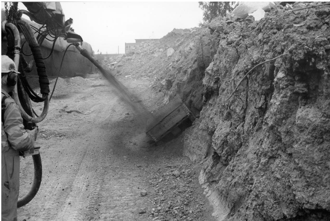
Figur 7-1 Sprøyting av prøvepall med resirkulert tilslag i betongen, Gaustadtrikken
