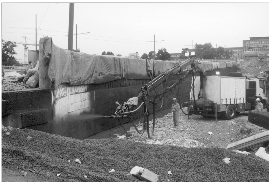
Figur 7-3. Utsprøyting av sprøytebetong med resirkulert tilslag på EPS -fylling, Gaustadtrikken
