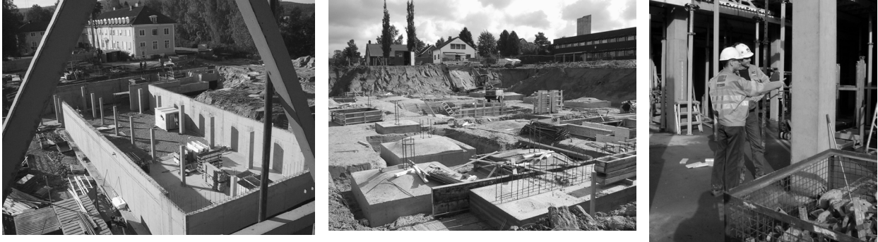
Figur 4-3. 37 % av grovt tilslag er erstattet med resirkulert tilslag i fundamenter, vegger og søyler på Sørumsand skole (Foto: Bente Lillestøl og Christine Hauck, Veidekke ASA)
