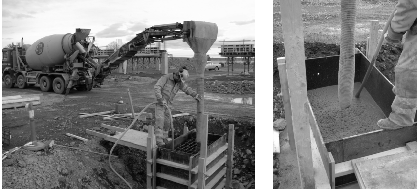
Figur 4-2 Støp av fundament med 20 prosent resirkulert tilslag på Fornebu (Foto: Bente Lillestøl, Veidekke ASA)
