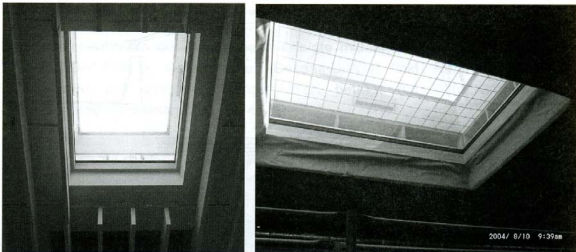
Figur 21 Takvindu (til venstre) og lyskuppel (til høyre, med sikkerhetsglass), sett innenfra.
