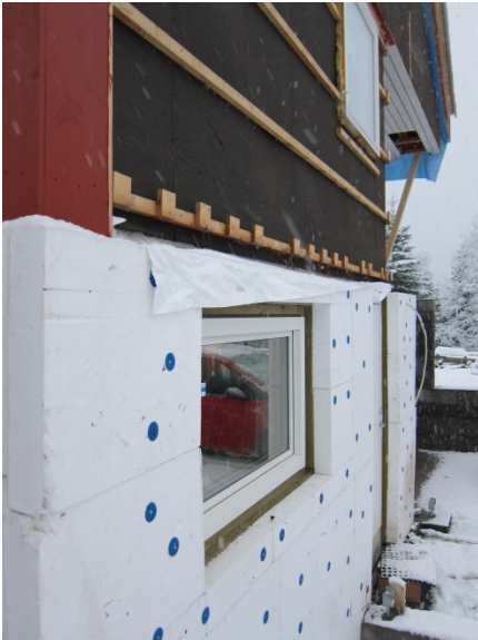
Isterdalen. Bilde 1: Utvendig etterisolering av kjeller
