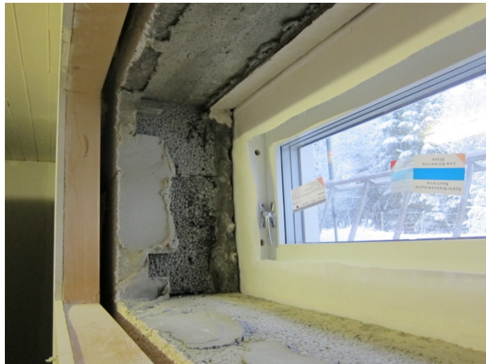
Bilde 2: Kjellervegg innvendig, nytt vindu og 7 cm innvendig utføring
