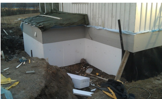
Rissa. Bilde 1: Drenering og etterisolering av kjellervegg
