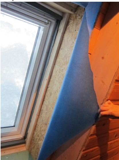
Isterdalen. Bilde 3: Nytt takvindu, 30 cm innblåst isolasjon mellom I-bjelker. Dampbrems ble etablert opp på gammelt tak.
