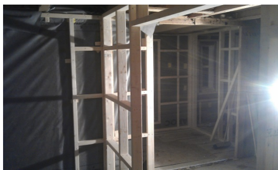
Bilde 2: 5 cm utføring innvendig og nyetablert diffusjonsbrems.
