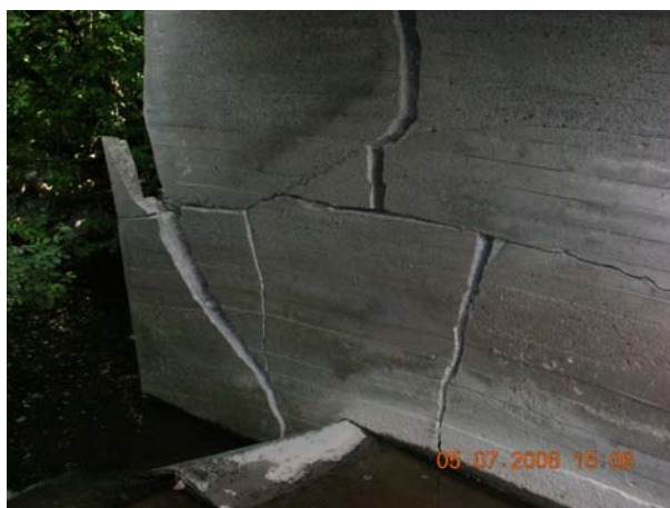
Engstad målestasjon i Hotran. Terskel og brukar i dårlig stand sannsynligvis grunnet frostpåvirkning (Foto: J. Deelstra).
