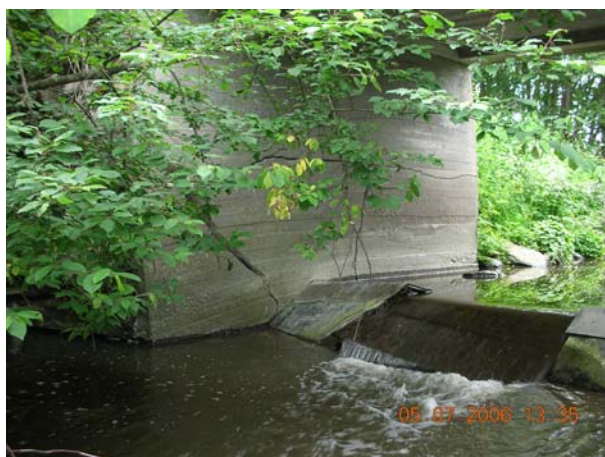
Engstad målestasjon i Hotran. Terskel og brukar i dårlig stand sannsynligvis grunnet frostpåvirkning (Foto: J. Deelstra).
