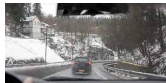
4.09 E16 Rustandalen sør for Skoglund, fra sjåføretet 31.08.2010 og 20.12.2008
