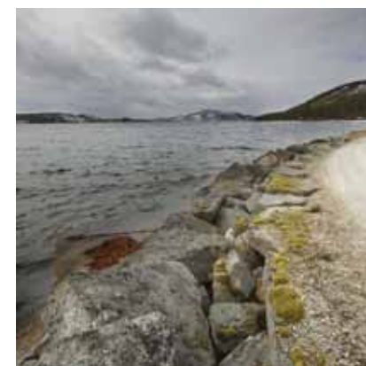
7.16 E10 Hamnøy, sikring mot havet
