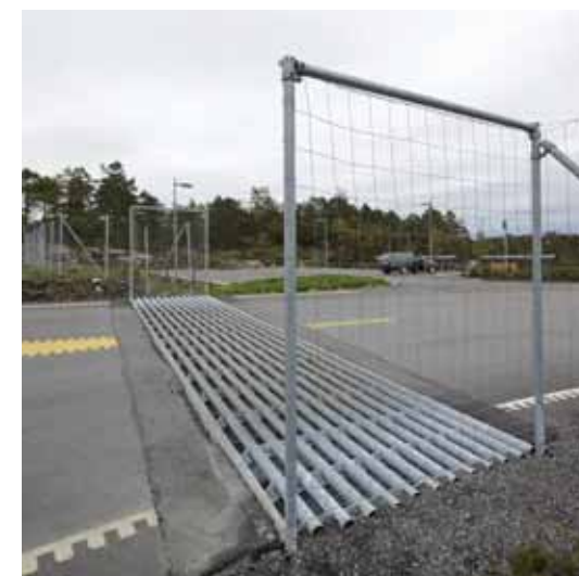
5.14 E18 mellom Lillesand og Grimstad, kanalisierende gjerder
