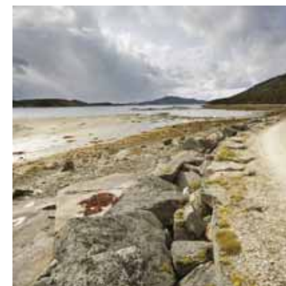
7.15 Nordkil, sikring mot springflo
