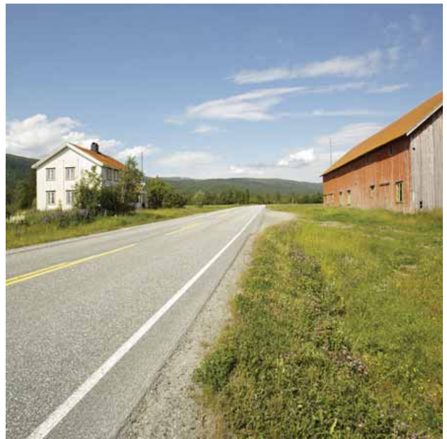
4.25 E6 Breifossmoen, veikryss gårdsvei og riksvei
