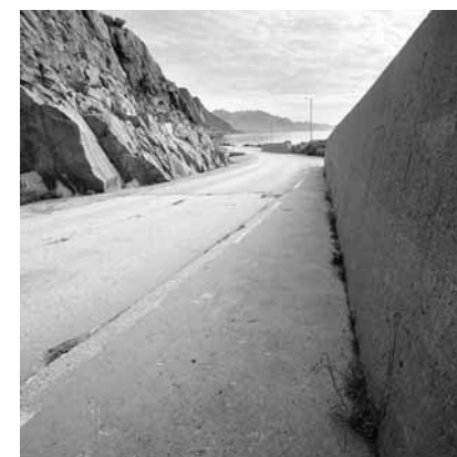
7.17 Eggum, sikring mot fjellveggen
