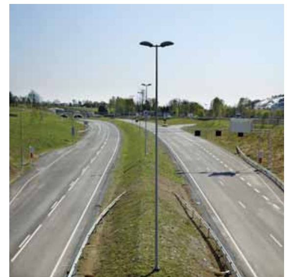
5.01 E16, Økrikrysset før åpning
