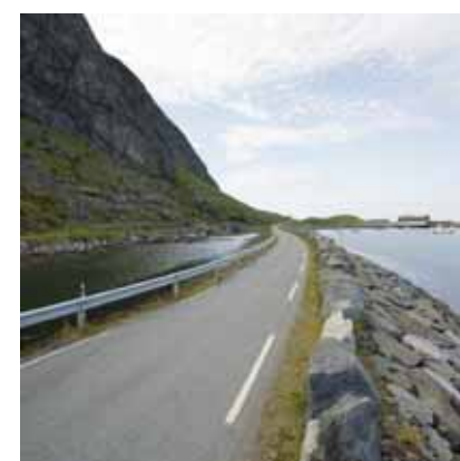
7.17 Eggum, sikring mot fjellveggen
