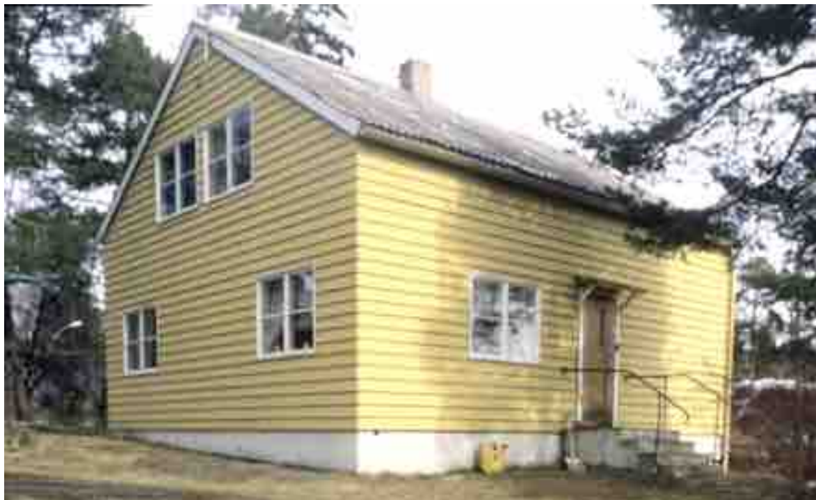
Figur 53: "Ekeberg-huset" ble reist av ingeniøren Olav Selvaag på Ekeberg i Oslo i 1948. Huset skulle være et eksempel på rasjonell boligbygging. Det ble reist i løpet av tolv uker høsten 1948, og var på mange måter det første moderne norske trehus bygd etter prinsipper som dominerer norsk boligbygging i dag. Huset, som nå er fredet, ble karakterisert som provisorisk. URL: https://snl.no/Olav_Selvaag , 25.02.2015, utsnitt av bilde.
