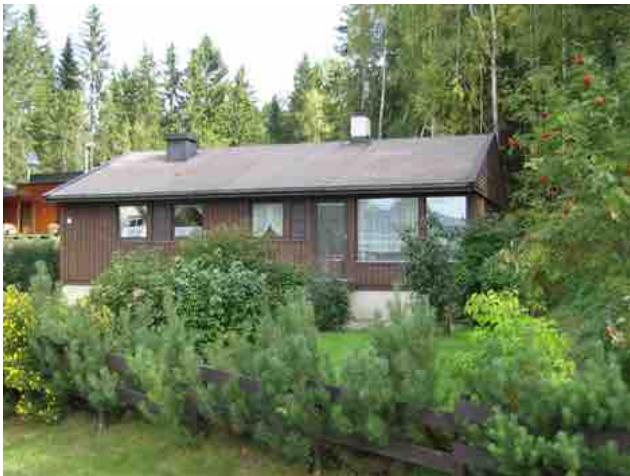
Figur 73: Et ferdighus utstilt på Maihaugen på Lillehammer. En enebolig på egen tomt var boligdrømmen for mange nordmenn fra 1960-tallet og fremover. Huset på bildet er bygget i fire seksjoner på fabrikken i Moelv og fraktet til ferdig grunnmur på Gardermoen. Det stod i Lyngveien 11 på Gardermoen i Ullensaker til Oslo lufthavn ble bygget i 1995. Foto: Kåre Hosar/Maihaugen. URL: http://www.maihaugen.no/Global/Maihaugen/Bilder%20Maih/Friluftsmuseet/Boligfeltet/1970.jpg , 22.02.2015.
