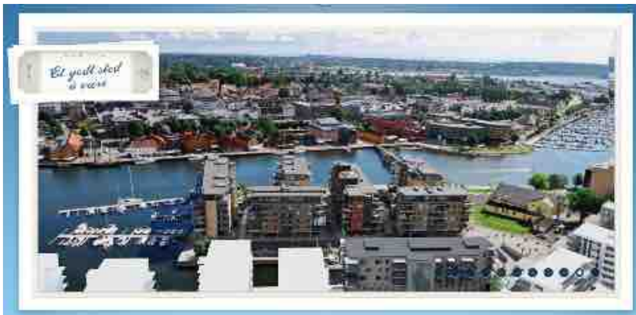
Figur 74: Reklame for utbyggingsområdet Kaldnes i Tønsberg sentrum. Tettheten i bebyggelsen har økt, men den er som under modernismen fortsatt basert på lamell eller punkthus hvor det lagt vekt på tilgangen til lys, luft og utsikt. URL: http://www.kaldnes.no/forside/ , 22.02.2105.
