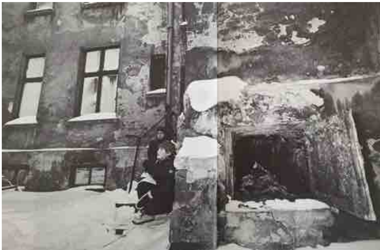
Figur 62: Bygård i Huitfeldsgate 33 i Oslo, fra boka "Oslobilder" av Åsmund Lindal (1982). "Klaskedo" – forbudt av Oslo Helseråd i 1973, men fortsatt i bruk i januar 1982. Bygården hvor bildet er tatt ble ilagt forelegg om utbedring av bygningsrådet i Oslo i 1981. Den hygieniske standarden hadde endret seg på de litt over 100 årene siden bygården ble bygget.
