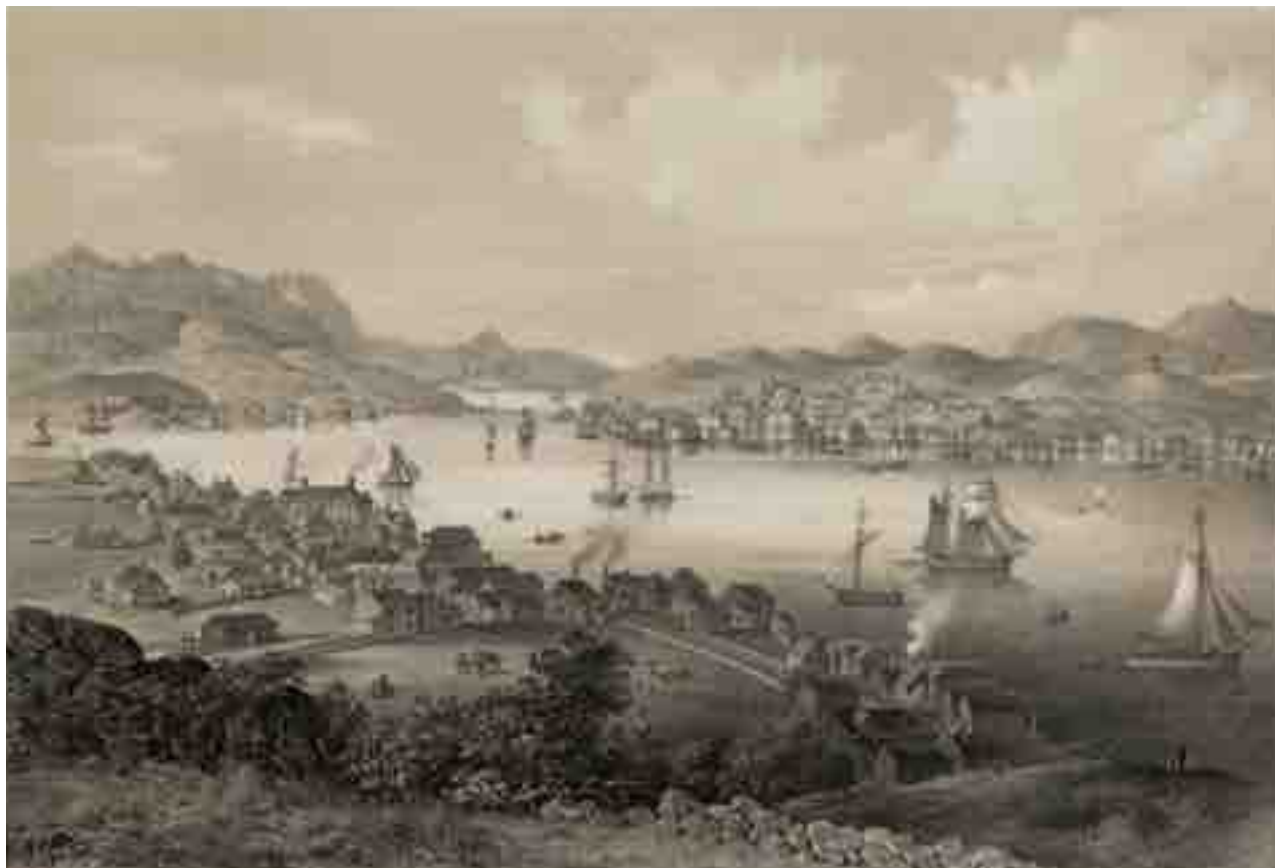
Figur 34: Kristiansund på 1840-tallet. Bebyggelsen langs sjøen var tett og befolkningen økte etter hvert som det ble mer aktivitet og bedre økonomi i byene. Bebyggelsen ble tilfeldig og hus ble satt opp uten en samlende plan eller med sikte på fremtidig infrastruktur. Illustrasjon hentet fra boken "Norge fremstillet i Tegninger" av Asbjørnsen, P.Chr. og utgitt av Chr. Tønsberg (no, 1848). http://upload.wikimedia.org/wikipedia/commons/1/1a/Norge_fremstillet_i_Tegninger_-_no-nb_digibok_2008112511001-133.jpg,07.09.2014 .
