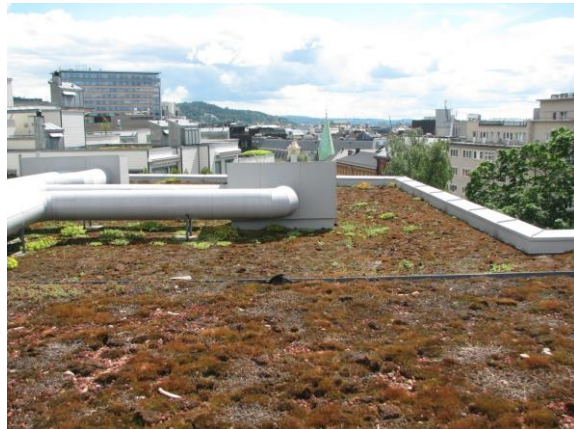
Figur 2.26: Sedumtak (Oslo kommune, 2013)
