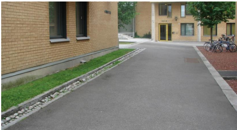
Figur 2.23: Åpen renner som fører overvannet til fordrøyningsdammen (Oslo kommune, 2013)
