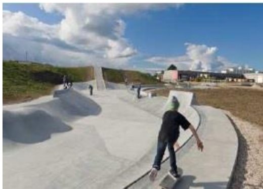
Figur 2.13: Tørr damanlegg i Roskilde med formål både som fordrøyningsareal (t.v) og flomveg (t.h) (Cowi, 2013)
