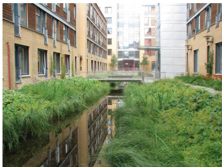
Figur 2.24: Vått fordrøyningsdam (Oslo kommune, 2013)
