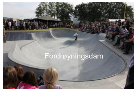
Figur 2.13: Tørr damanlegg i Roskilde med formål både som fordrøyningsareal (t.v) og flomveg (t.h) (Cowi, 2013)
