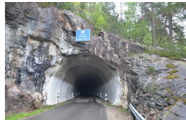
Figur . Tunnel ved Høgefjell
