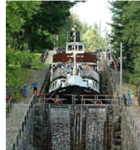
Bilde 9: Vrangfoss sluse, den største av slusene
