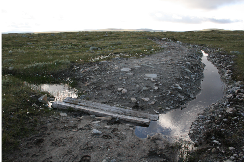
Figur 4-28: Det er grøftet i et eldre kjørespor og massene er brukt til å forhøye slepa. Naturlig grøft til høyre på dette bildet.
