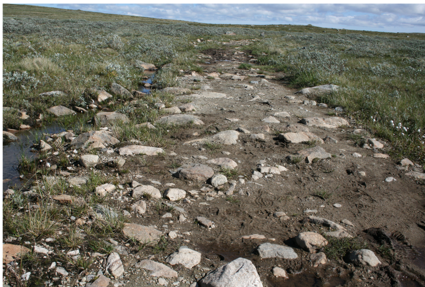
Figur 4-29: I partier med mye stein ble større stein gravd ned under slepa slik at fremkommeligheten ble bedre.
