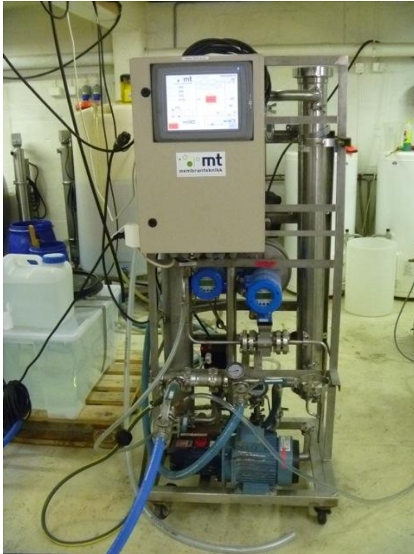
Figure 16: Experimental setup at Membraneteknikk AS, Flekkefjord
