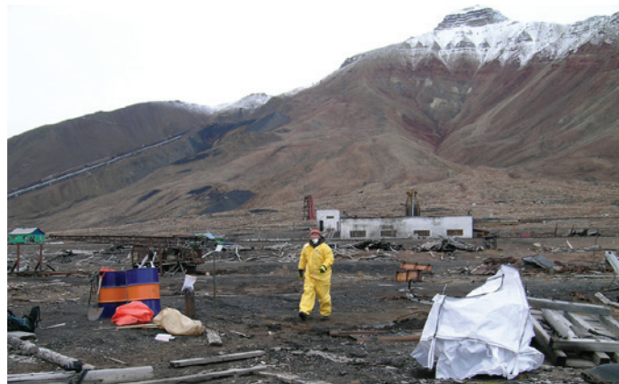
Fjerning og sanering av elektrisk høyspentutstyr som har lekkende PCB, Pyramiden.
