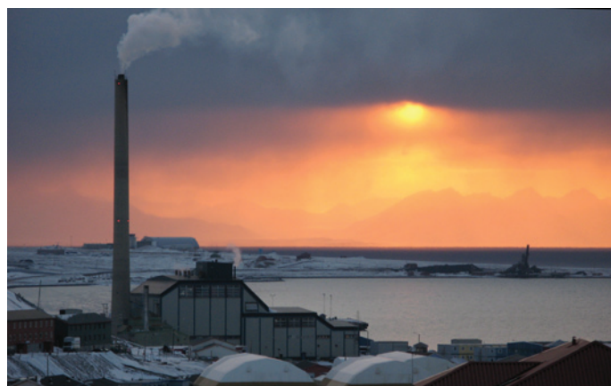
Den kulldrevne kraftstasjonen i Longyearbyen er en kilde til utslipp av bl.a. kadmium, kvikksølv og bly til atmosfæren. Foto: Jon Aars, Norsk Polarinstitutt
