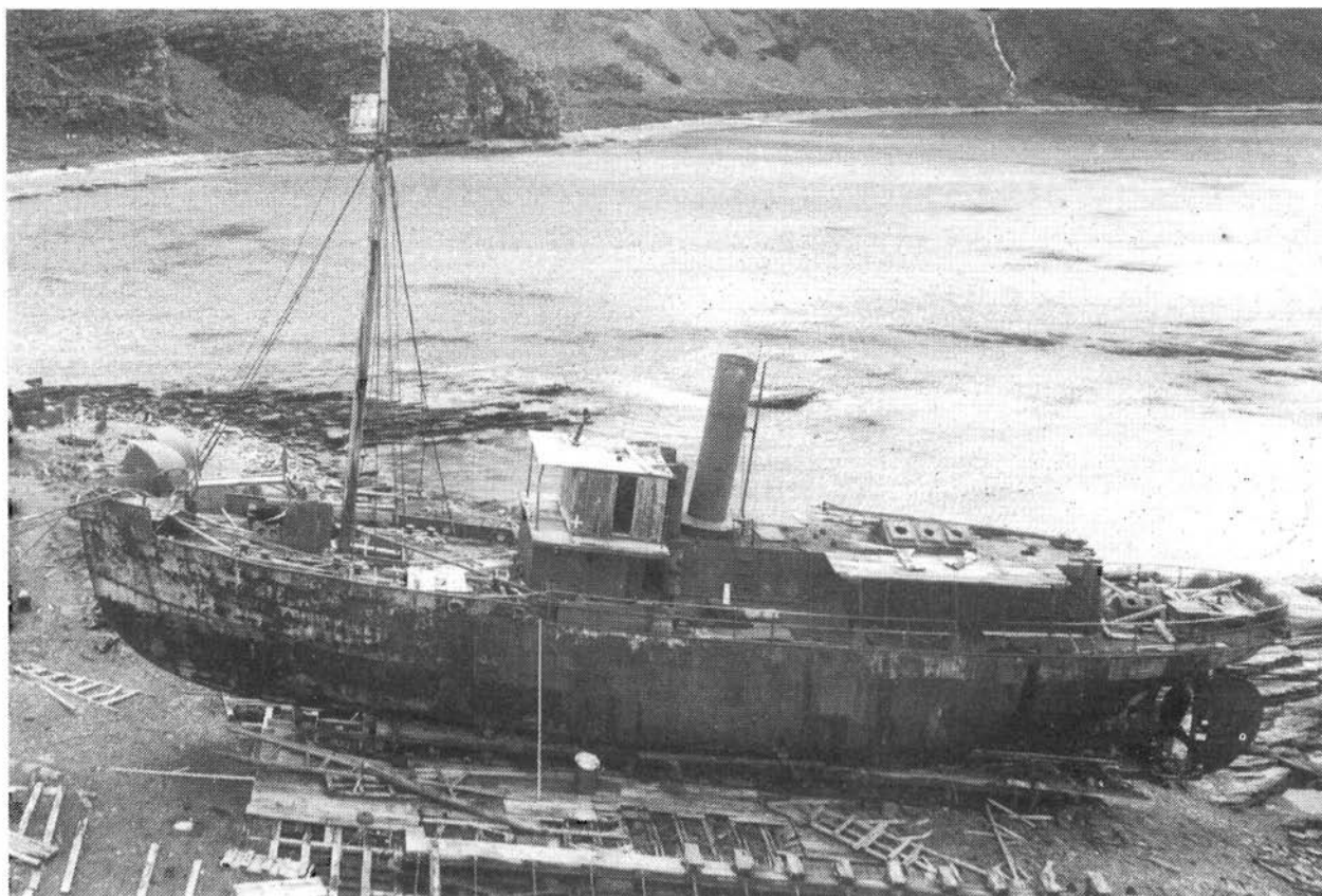
Figur 10 Hvalbåten Karrakatta, bygget i 1912 ved Akers Mek. Verksted, ligger på slipp i Husvik. En spesiell detalj ved fartøyet er "fleskekassa" - en kort bro montert bak lemmene. Her kunne skytteren søke tilflukt i høy sjø.
