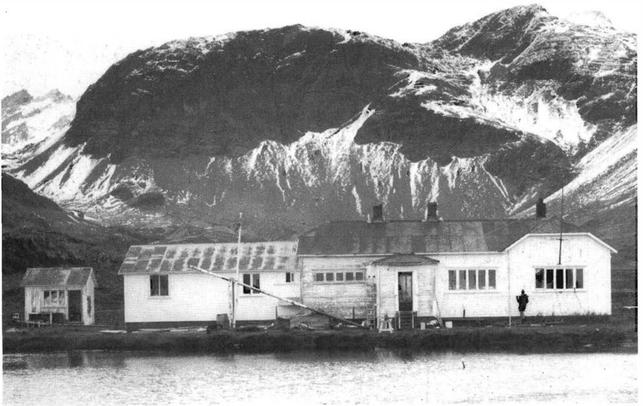
Figur 9 Bestyrerboligen i Husvik. Huset er ombygget og påbygget en rekke ganger. Under panelet i inngangspartiet skjuler det seg en tidligere veranda i sveitserstil. Bestyrerens kontor lå umiddelbart til venstre for inngangen, bak den smale vindusrekken. Det lavere tilbygget til venstre rommet blant annet toaletter, vaskerom og proviantlager.
