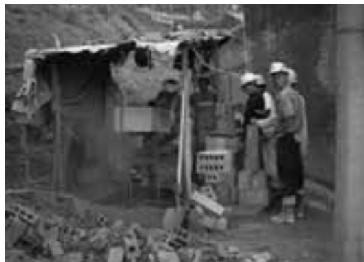
Figura 7. Corte de ladrillo, actividad generadora de material particulado.
