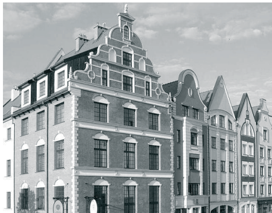
Fot. 1. Elbląg, kamienice staromiejskie
