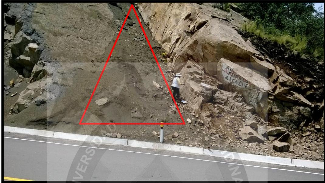
FOTO N° 02 Muro de contención tradicional en riesgo.
