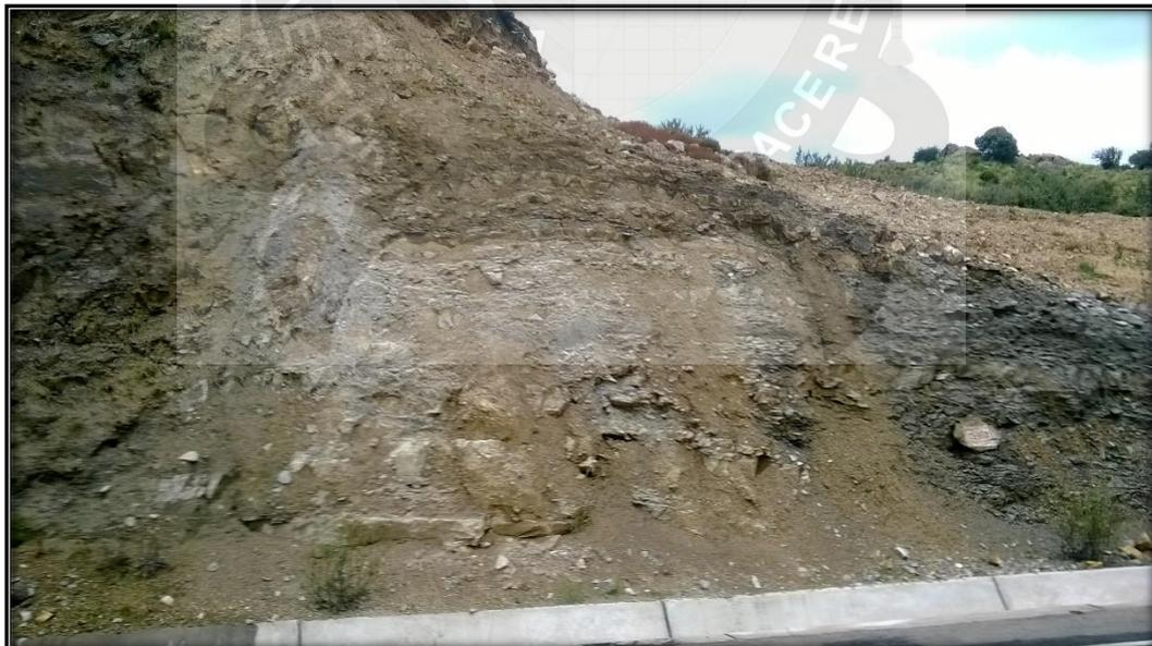
Tramo 04, talud en corte inestable. Prog. 15+120
