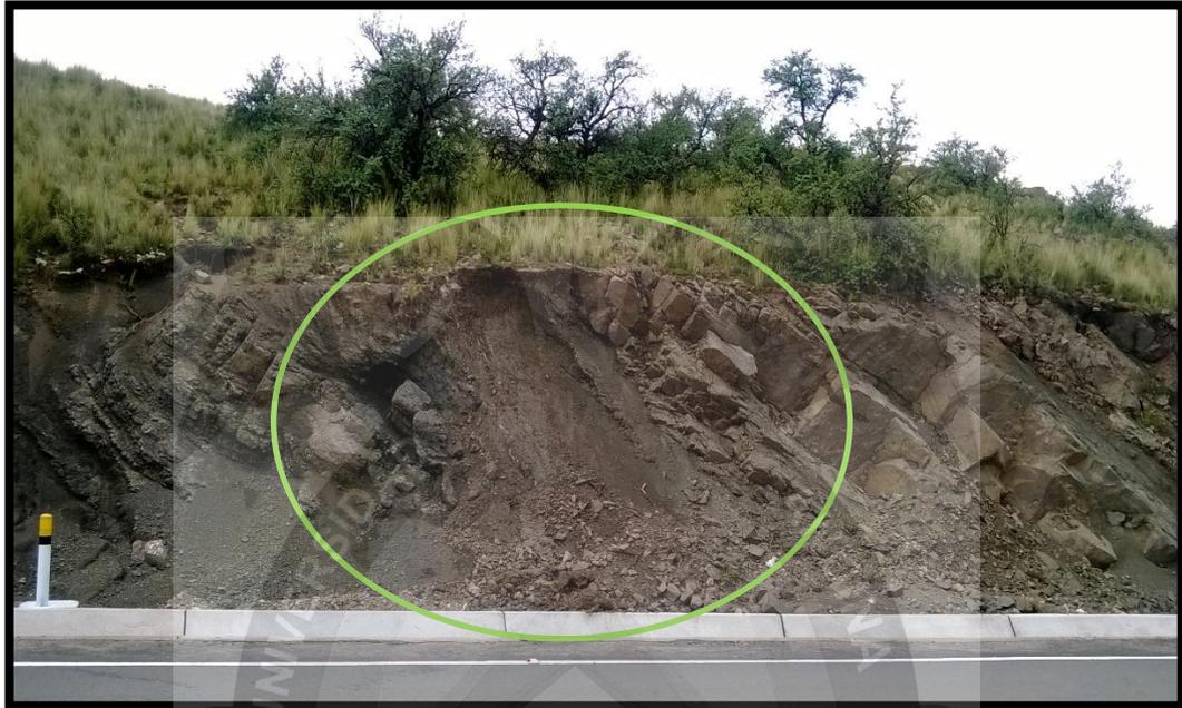
FOTO N° 04 Riesgo permanente, debido a la inestabilidad del talud.
