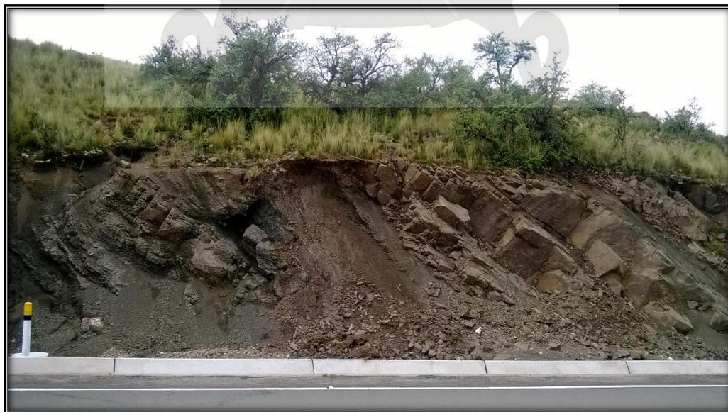
**Tramo 03, talud en corte inestable. Prog. 14+810**
