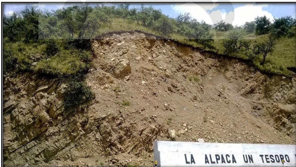
Tramo 01, talud en corte inestable. Prog. 14+230
