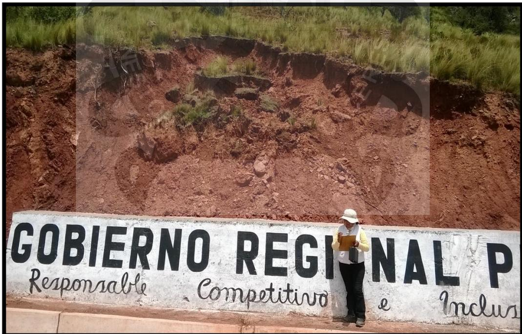
FOTO N° 03 Deslizamiento de talud (Roca suelta y suelos finos) de manera permanente.
