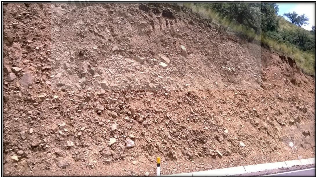
Tramo 02, talud en corte inestable. Prog. 14+610
