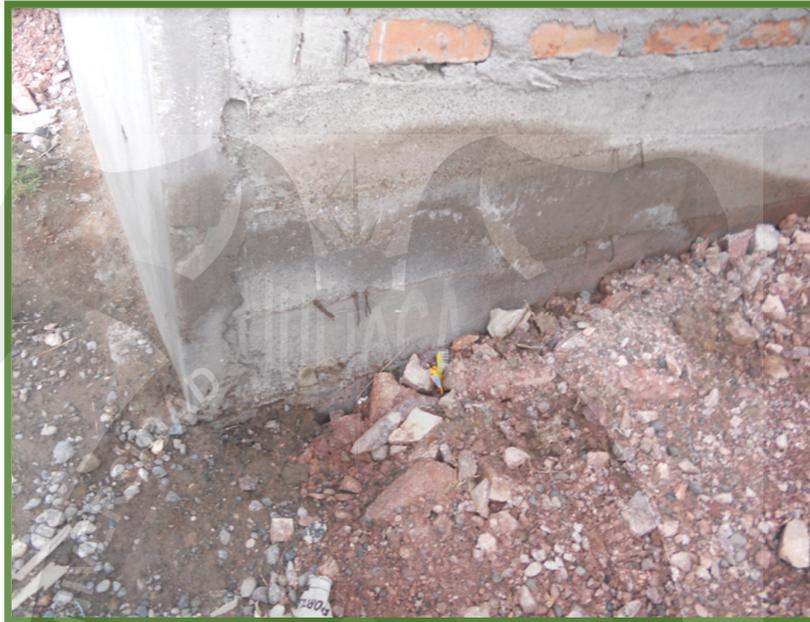
**4.6.4 INCIDENCIA DEL AGUA Y SUELOS CONTAMINADOS A LA RESISTENCIA DEL CONCRETO DE ESTRUCTURAS DE CIMENTACIÓN EN VIVIENDAS EN LA URB. ALFONSO UGARTE DE LA CIUDAD DE JULIACA.**
