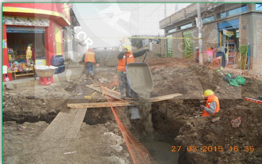
FOTOGRAFÍA 22 CONSTRUCCIÓN DE BUZONES DE DESAGÜE
