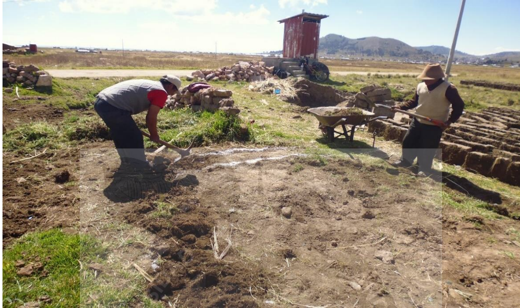
VISTA13: SE OBSERVA LA EXCAVACION DE ZANJAS PARA SU RESPECTIVA CIMENTACION
