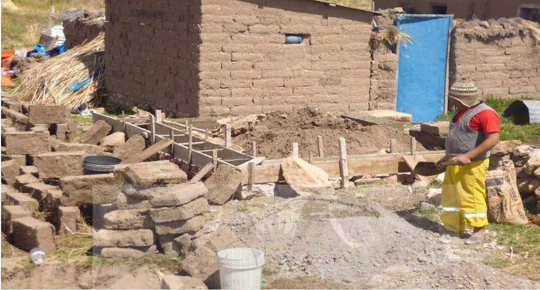
VISTA 15: SE OBSERVA EL ENCOFRADO Y VACIADO DEL SOBRECIMIENTO DE CONCRETO DE C:H 1:8 + 8% PM
