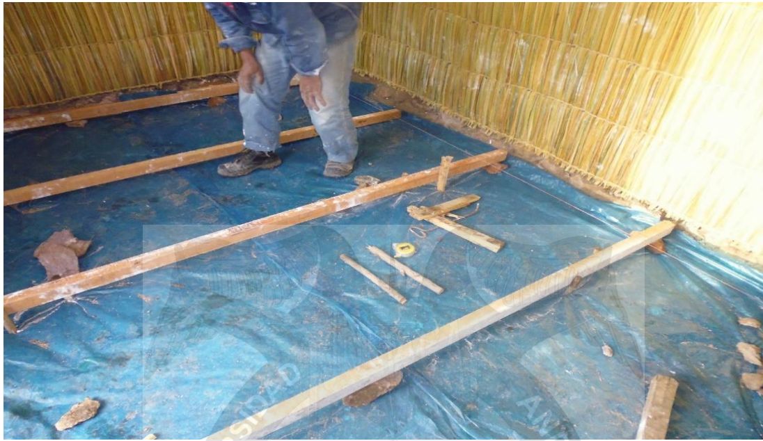
VISTA 23: SE OBSERVA EL COLOCADO DEL PLASTICO PARA EVITAR LA CAPILARIDAD Y LOS DURMIENTES PARA EL ENTABLADO INTERIOR DE LA VIVIENDA
