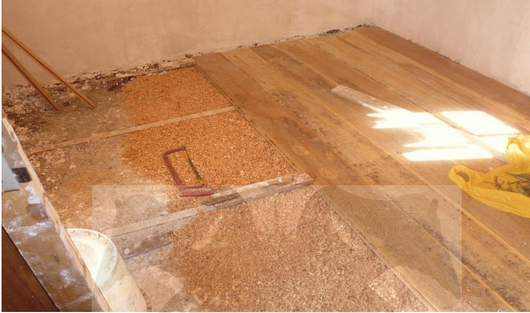
VISTA 25: SE OBSERVA EL COLOCADO DE TABLONES Y ASERRIN EN EL PISO DE LA HABITACION
