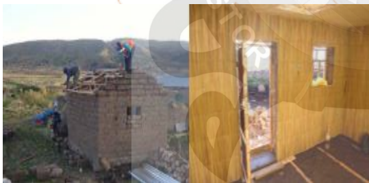
CONSTRUCCIÓN DEL PROTOTIPO DE VIVIENDA DE ADOBE ACONDICIONADA TÉRMICAMENTE EN LA COMUNIDAD DE PALERMO RIO BALADO UBICADO A 8800 M.S.N.M. DEL DISTRITO DE JULI EN LA PROVINCIA DE CHUQUIBUT
