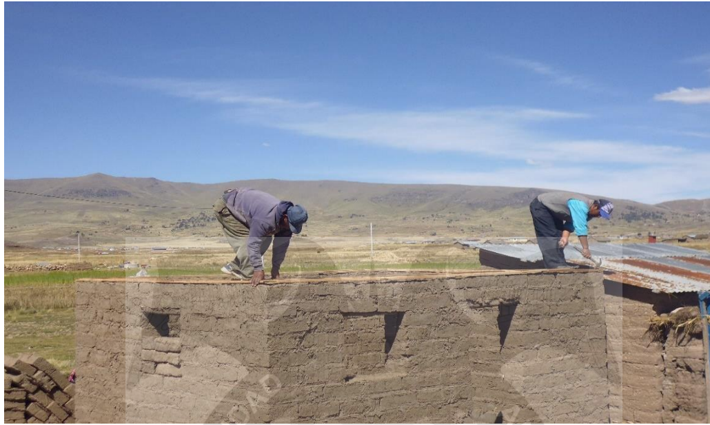
VISTA 17: SE OBSERVA EL COLOCADO DE LA VIGA COLLAR
