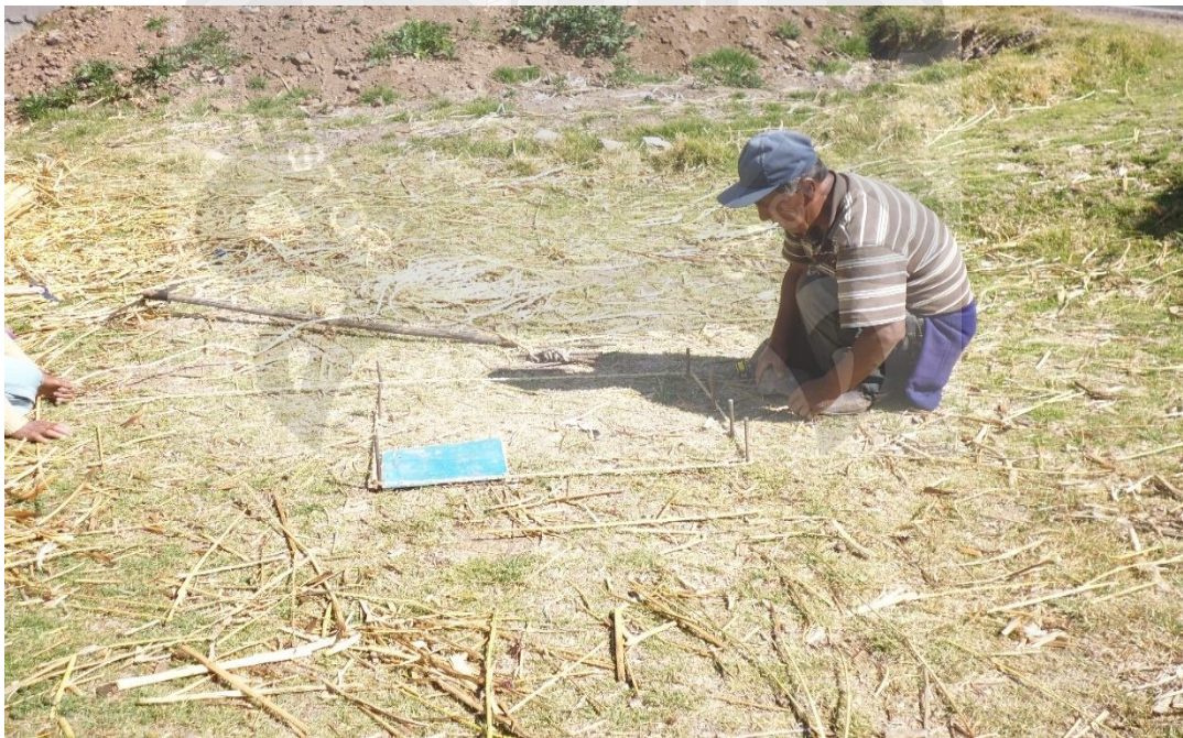
VISTA 02: SE OBSERVA EL COLOCADO DE ESTACAS DE FIERRO DE ½" PARA EL TEJIDO DE LA K'ESANA DE TOTORA
