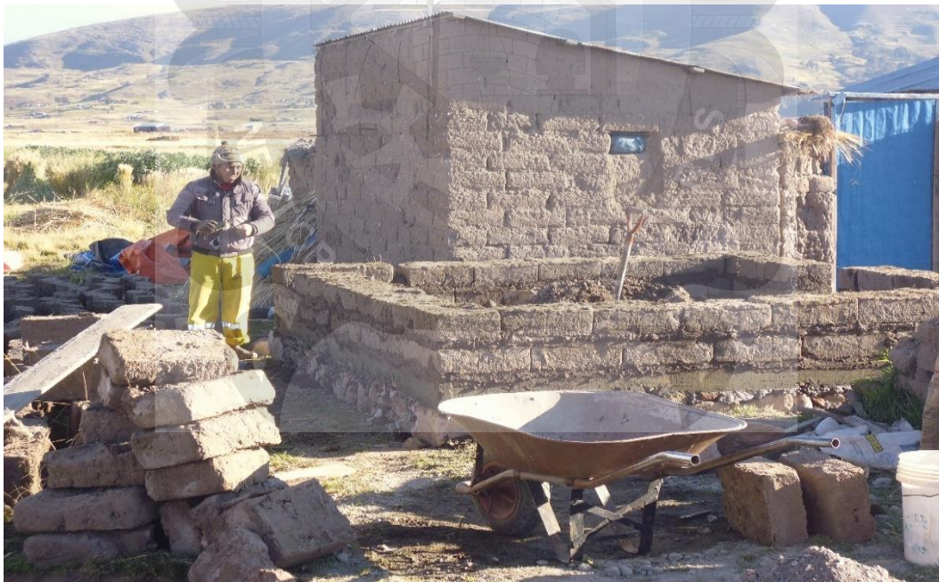
VISTA 16: SE OBSERVA EL ASENTADO DE LAS HILADAS DEL MURO DE ADOBE
