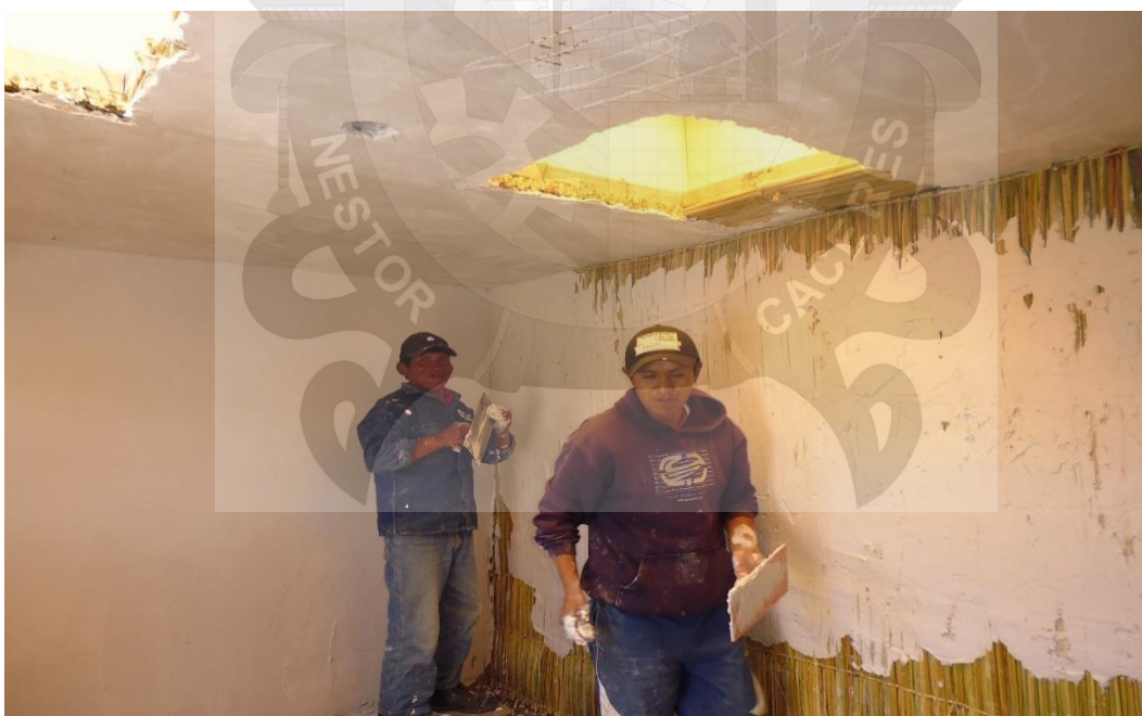
VISTA 22: SE OBSERVA EL ENLUCIDO CON YESO EN LOS PANELES DE K'ESANA EN EL INTERIOR DE LA VIVIENDA
