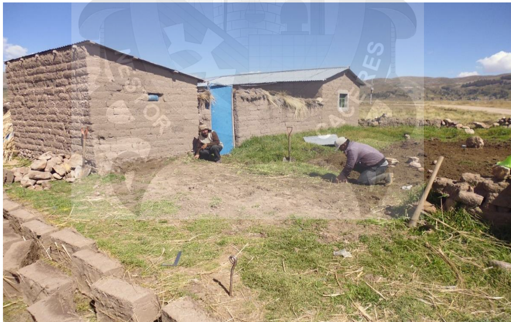
VISTA 12: SE OBSERVA EL TRAZO Y REPLANTEO PARA SU CIMENTACION DE LA VIVIENDA
