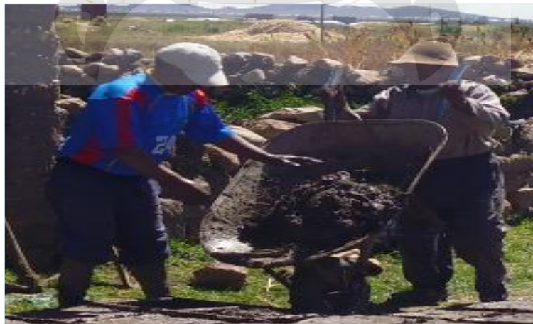
Llenado de barro a la adobera por los operarios
