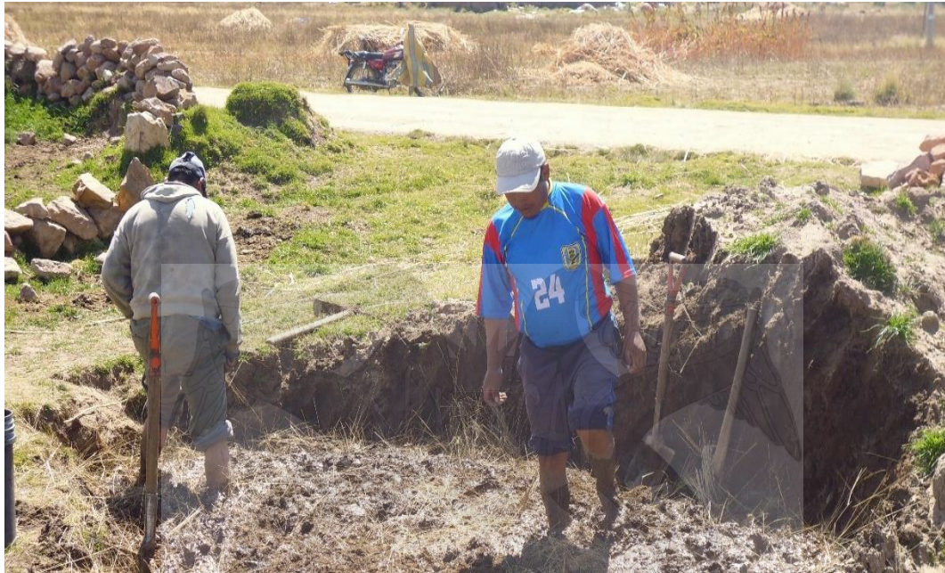
VISTA 09: SE OBSERVA LA CANTERA Y PREPARACION DE BARRO PARA ELABORAR ADOBES
