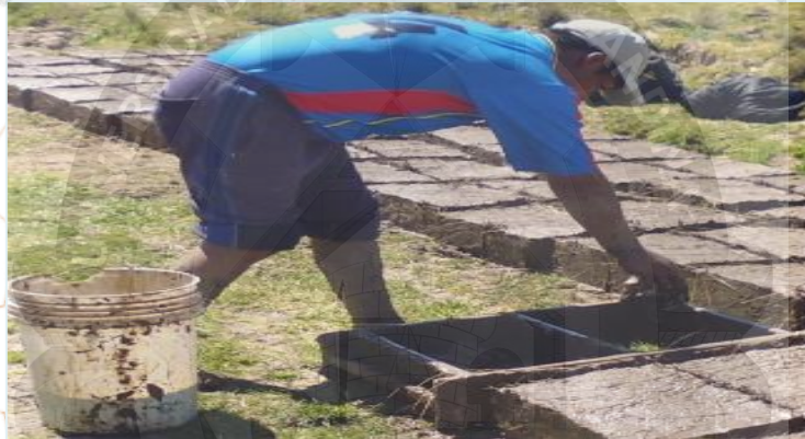
Operario realizando la Limpieza de la adobera
