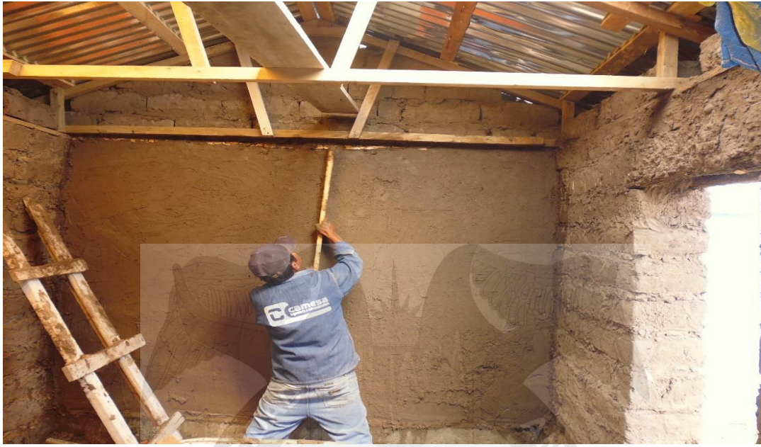
VISTA 19: SE OBSERVA EL REVESTIMIENTO EN EL INTERIOR DE LA HABITACION CON MORTERO DE BARRO COMO PRIMERA CAPA PARA EL AISLAMIENTO TERMICO
