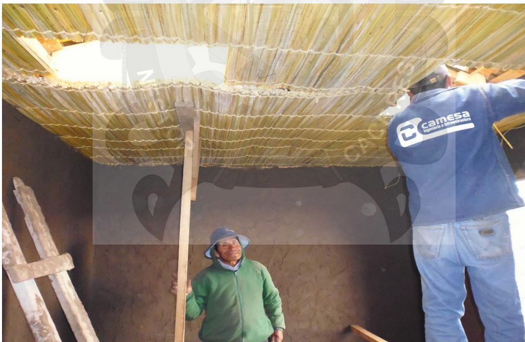
VISTA 20: SE OBSERVA EL COLOCADO DE LA K'ESANA DE TOTORA EN EL CIELORASO
