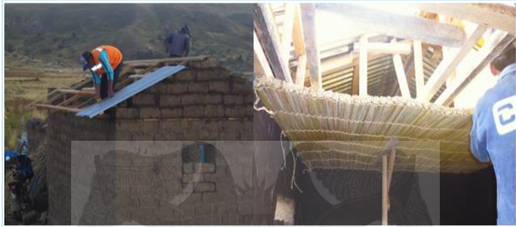
Colocado en la estructura del techo con calamina y a la derecha el colocado de la K'esana de Totora en el cielo raso
