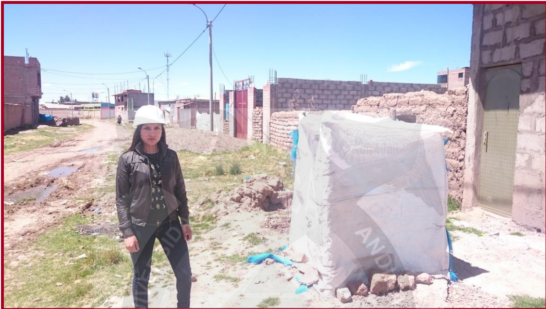
FOTOGRAFÍA N° 15: Silo de desague en el Jr. Napo, Manzana D-12, Lote 1, Urbanización Taparachi – III Sector – Juliaca.
