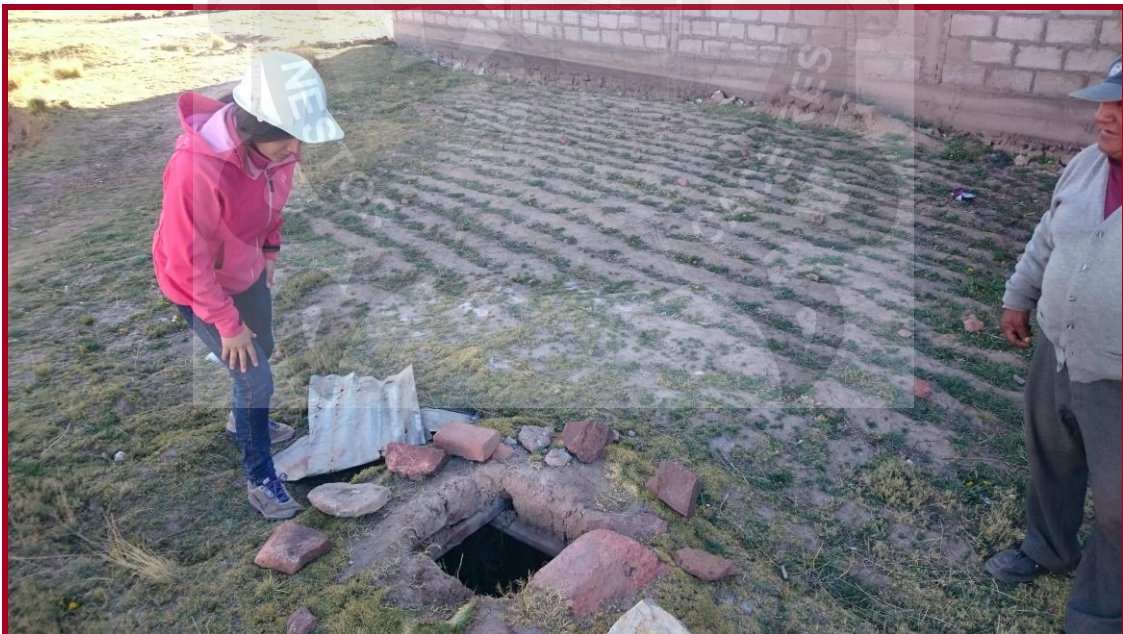
FOTOGRAFÍA N° 10: Pozo doméstico en el Jr. Eufrates, Manzana D-7, Lote 1, Urbanización Taparachi – III Sector – Juliaca.
