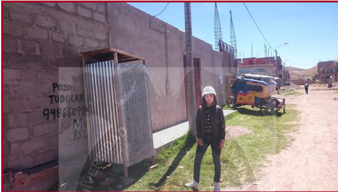
FOTOGRAFÍA N° 13: Silo de desague en el Jr. Putumayo, Manzana D-13, Lote 1, Urbanización Taparachi – III Sector – Juliaca.
