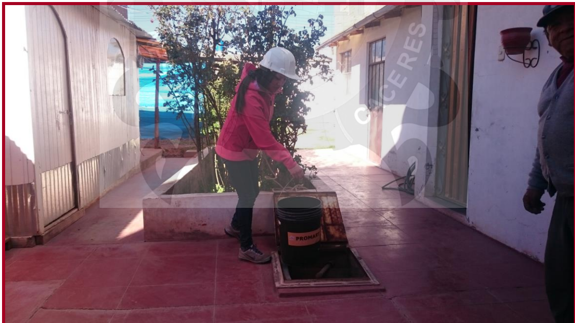
FOTOGRAFÍA N° 02: Pozo doméstico en el Jr. Senegal, Manzana F-9, Lote 1, Urbanización Taparachi – III Sector – Juliaca.
