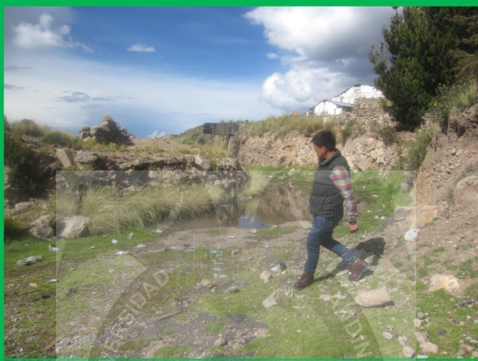
FOTOGRAFÍA 09: Se observa la contaminación del agua por derrame de asfalto en el campamento Patallani km. 9+000 de la vía Puno – Juliaca.
