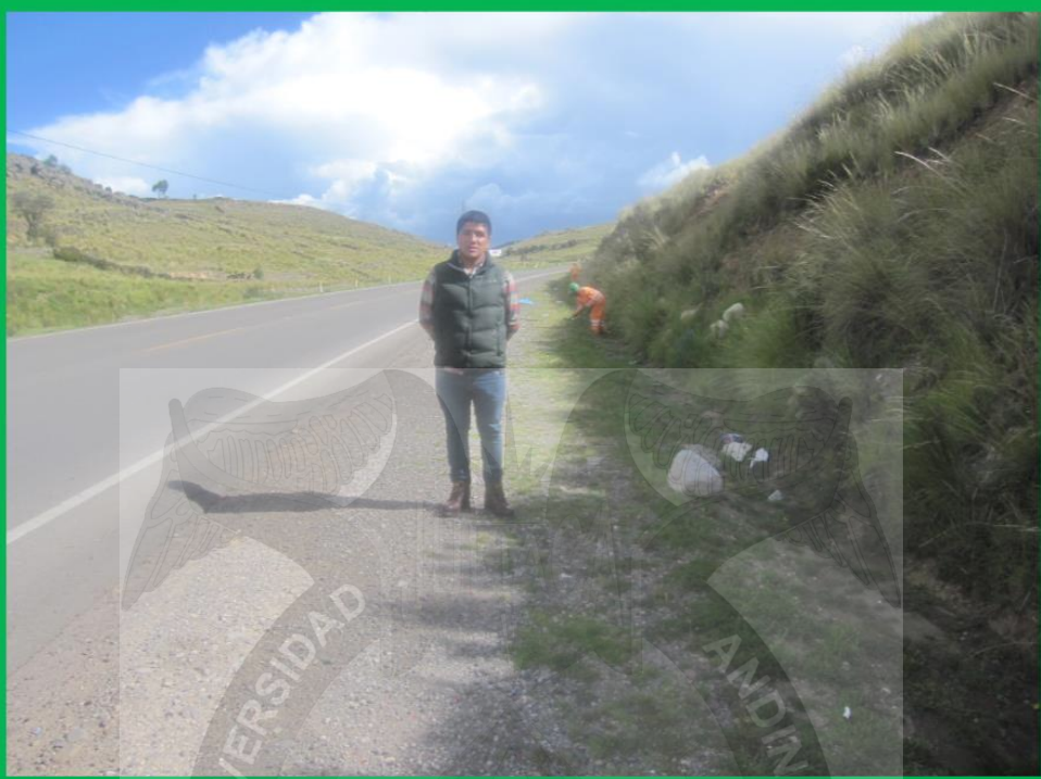
FOTOGRAFÍA 01: Se observa el desarrollo de actividades de mantenimiento en el km. 12+000 de la vía Puno – Juliaca.
