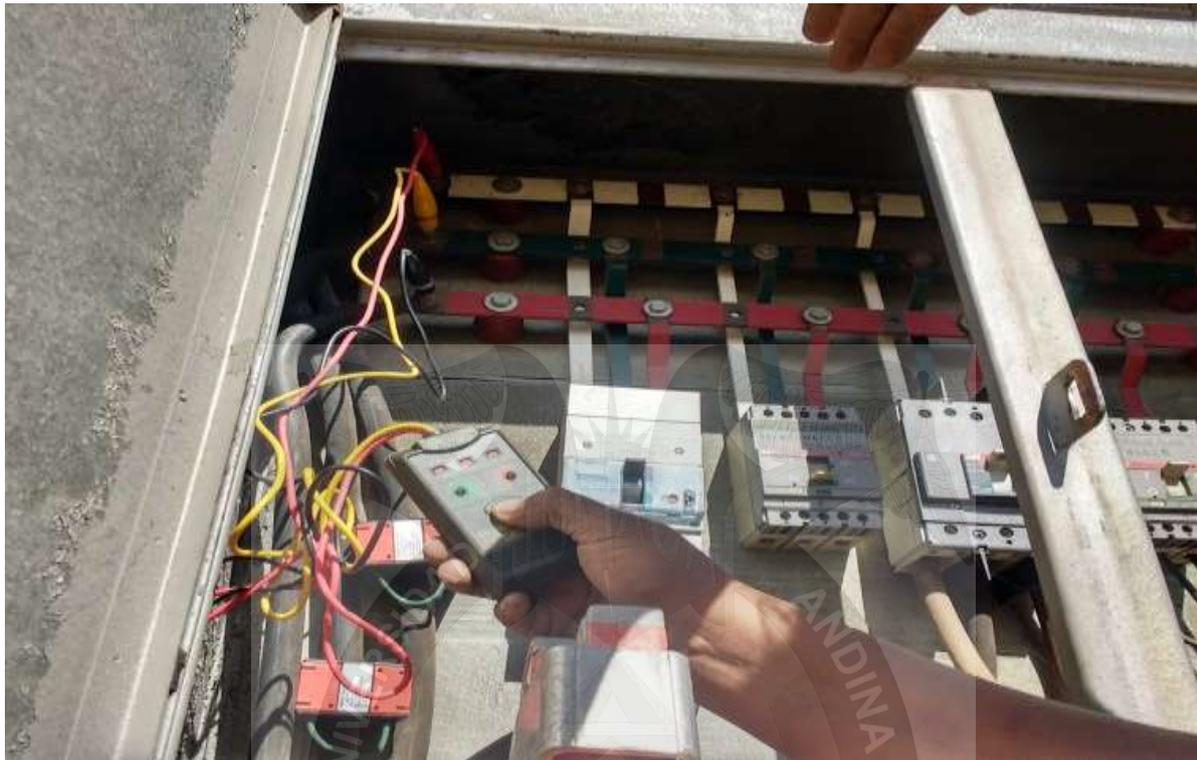
Foto N°1: Verificando fases con el instrumento fasímetro para instalar el medidor
