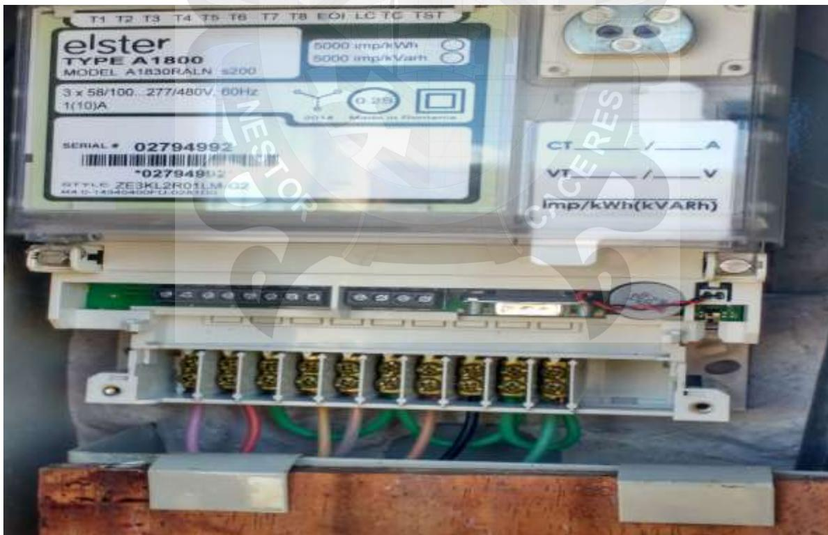
Foto N° 2: Instalación del medidor Elster A1800
