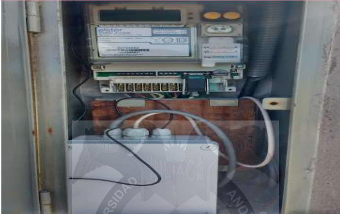
Foto N°3: Instalado del modem en marca centurión
