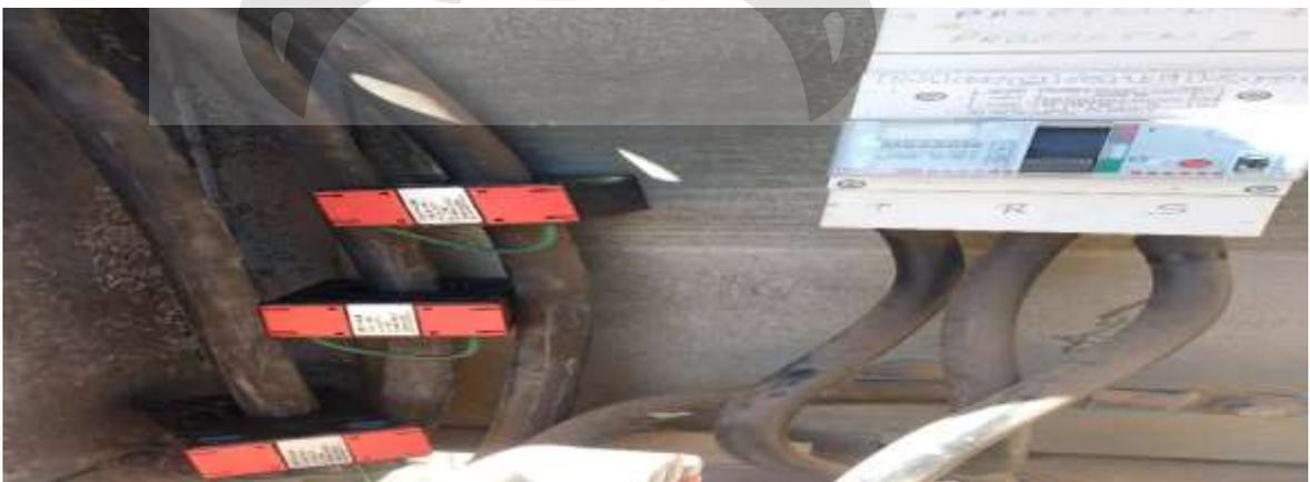
**Figura N° 3.3: Instalación del transformador de corriente en la bajada a las barras del tablero de distribución.**
