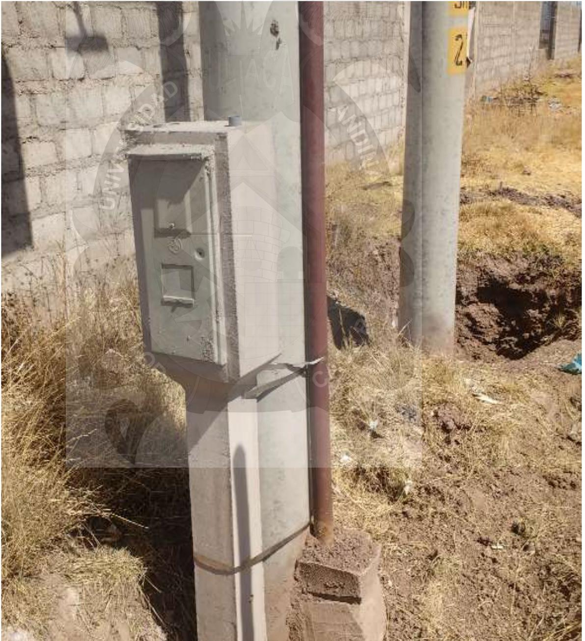
**Figura N° 3.2: Montaje de la caja del medidor trifásico con concreto armado vibrado**
