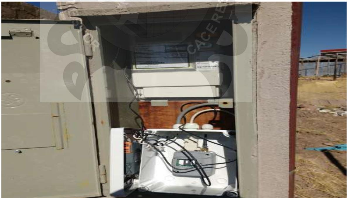
**Figura N° 3.4: Instalación del modem al medidor**
