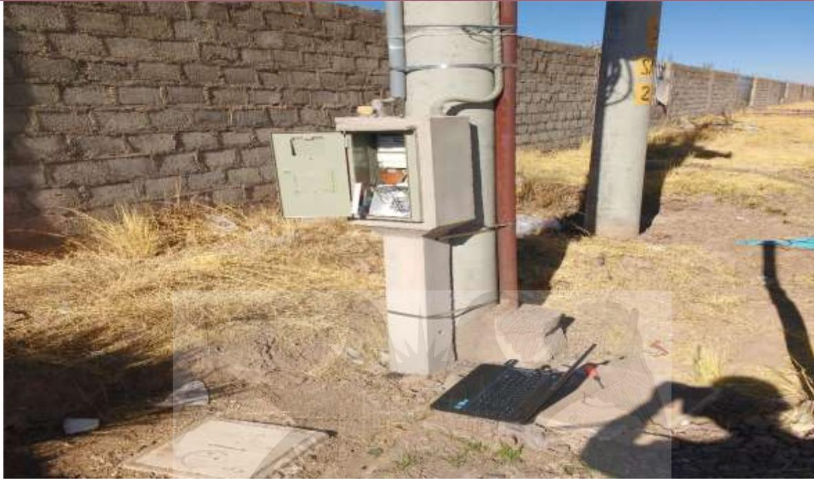
Foto N°5: Realizando la comunicaron de modem centurión con el programa metercat
