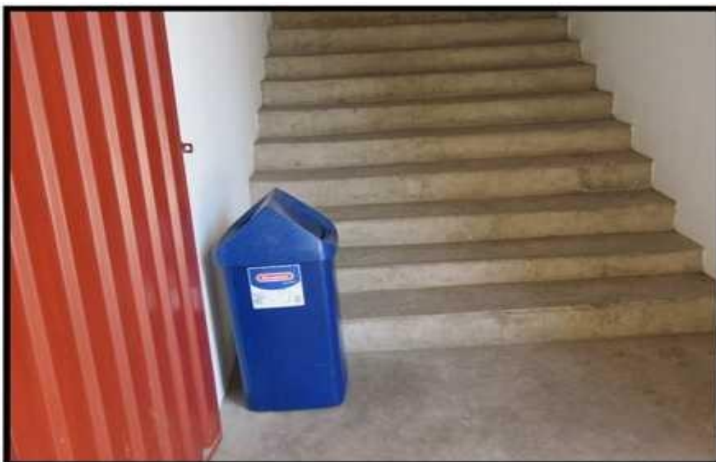
Fotografía 2 Tacho encontrado en el quiosco del primer piso
