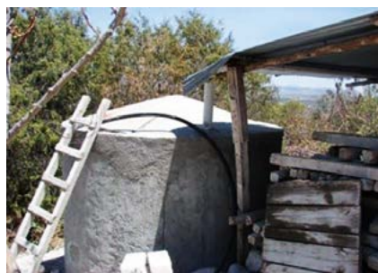
Figura 3. Cisternas de ferrocemento para la captación de agua de lluvia.
