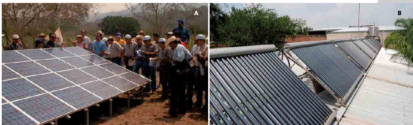
Figura 3. A: Demostración de paneles solares (energía fotovoltaica) a productores en El Fuerte, Sinaloa, México. B: Calentamiento de agua, calentadores solares evacuados en Rastro TIF, Puente Grande, Guadalajara, Jalisco, México.
