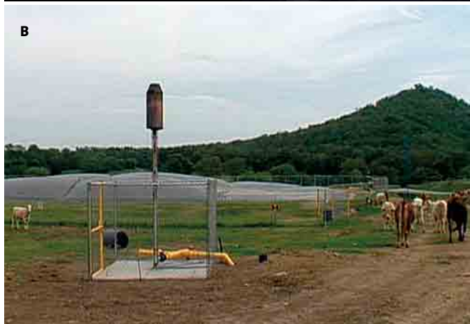
Figura 6. A: Congreso mundial de energía renovable. B: Quemador de biogás y bio-digestor al fondo. Granja Ana Margarita, Allende, N.L., México.
