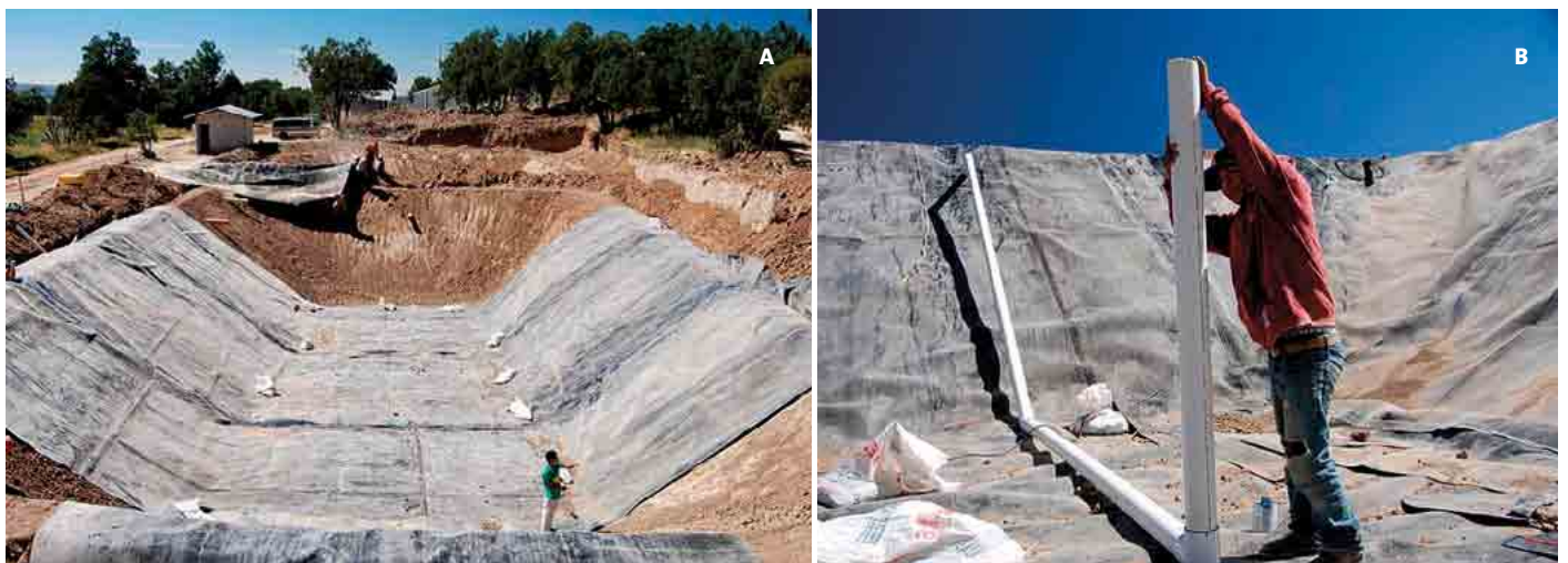
Figura 9. A: Excavación de trinchera. B: Instalación de tubos de agitación.
