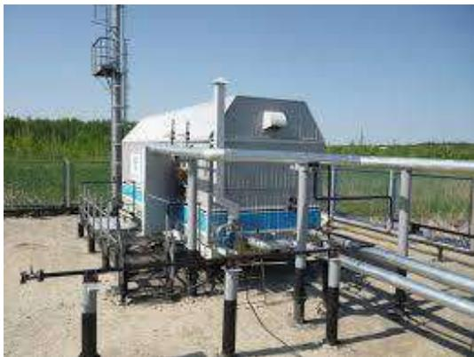
**Рис. 3 Вакуумная компрессорная станция на Игольско-Таловом нефтяном месторождении**
