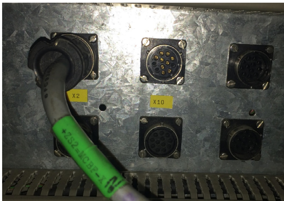
Slika 7.3: Priklučitev inkrementalnega dajalnika
