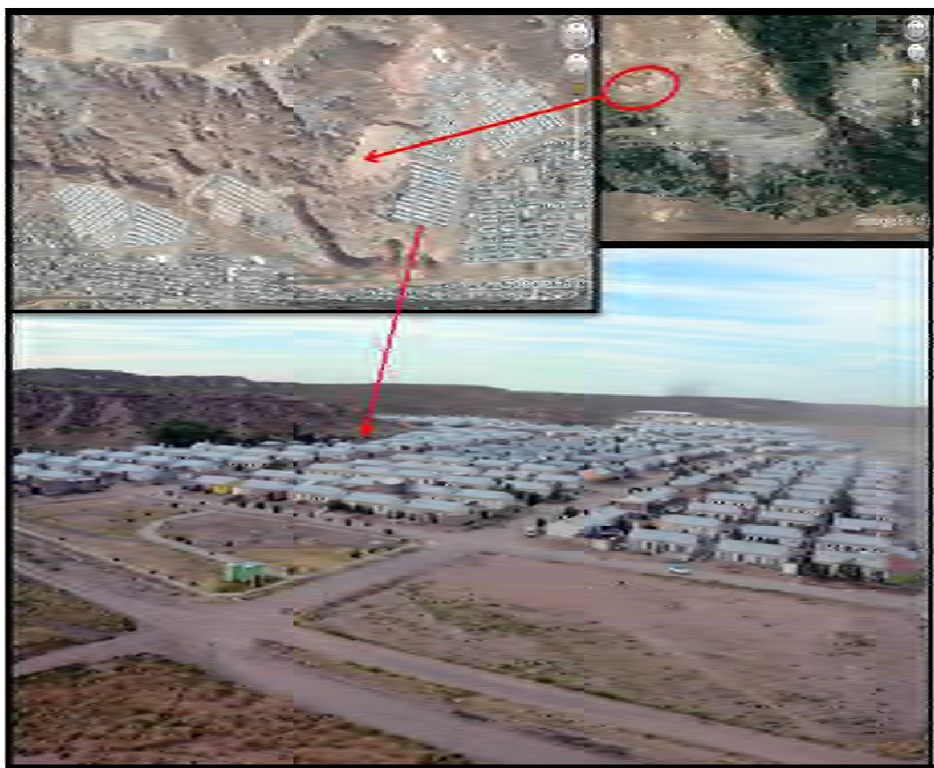
Figura 8.13: Construcción de planes de viviendas en el noroeste del municipio de Neuquén. Sector Z1. Año 2015
