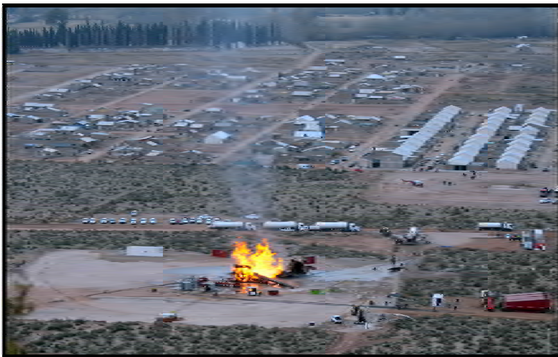
Figura 8.22: Incendio de pozo de gas en el municipio de Plottier, año 2013
