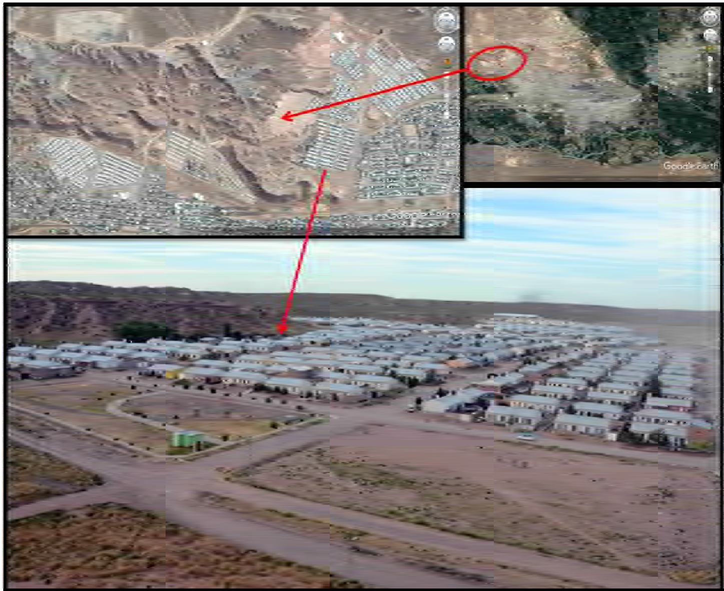
Figura 8.13: construcción de planes de viviendas en el noroeste del municipio de Neuquén. Sector Z1. Año 2015
