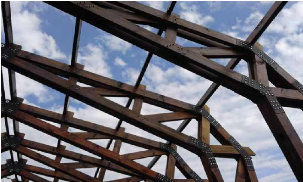
Montaje del salón de usos múltiples, Bariloche, Argentina (2017)
