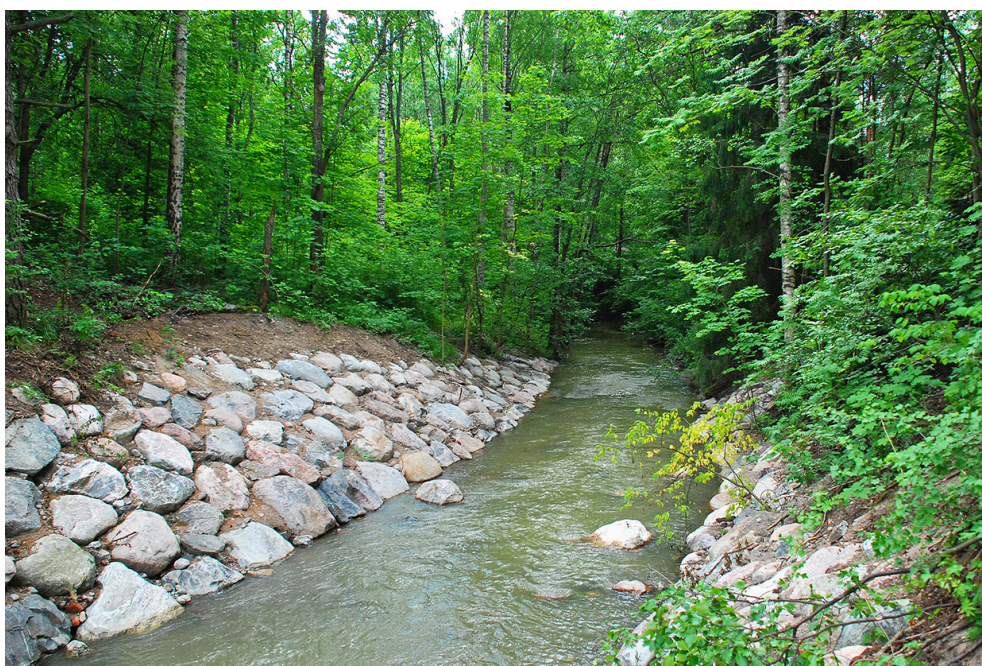
Kuva 31. Uomaeroosion hillitsemiseksi kivettyä puron rantatörmää. Kuva: Milla Popova/YHA kuvapankki.
