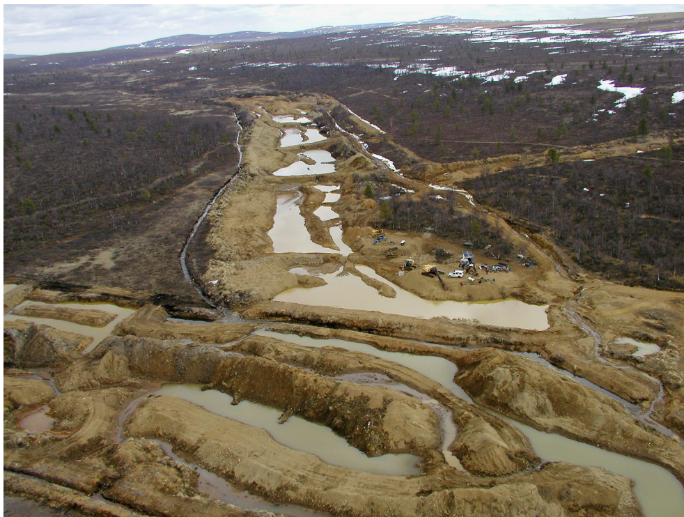
Kuva 19. Koneellista kullanhuuhdonta Lapissa. Kaivostoiminnan maanmuokkaus ja louhinta lisää maaperän eroosiota ja voi aiheuttaa haitallista kiintoainekuormitusta vesistöihin, mikäli vesien käsittely on puutteellista. Kuva: Tarmo Oikarinen/YHA kuvapankki.
